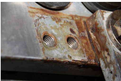
Bild 3-43 – BV 2: Kontakt Winkellasche vor Umbau
