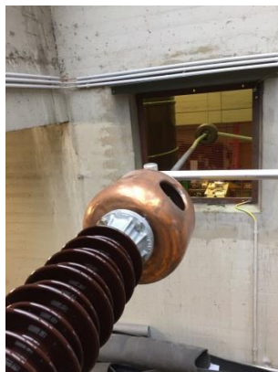
Bild 3-57 – Verbindungsisolator
