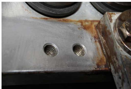
Bild 3-47 – BV 2: Kontakt Winkelplatte nach Umbau
