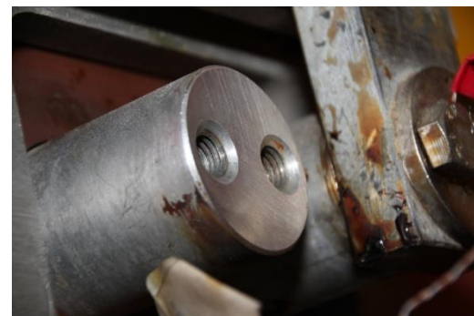
Bild 3-48 – BV 2: Kontakt Primärleiter nach Umbau
