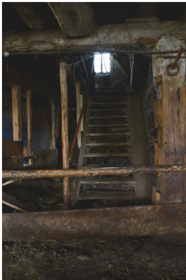
Abbild 3.4.36 Abgang in den Stall Abbild 3.4.37 Futterstelle
