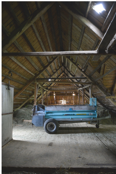
Abbild 3.4.24 Scheune Abbild 3.4.25 Dachraum über Wohntrakt
