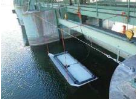
Abbildung C 1-6: FLOATING Antenne fixiert (Biomark, 2016)
