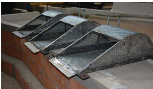
Abbildung B 2-4: Geschiebekörbe neu
