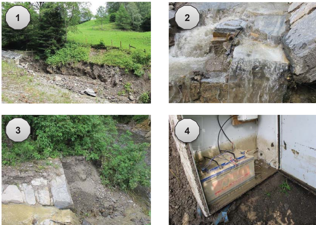
Abbildung B 2-11: (1) Hangrutschungen (2) Bruch der Gerinnesohle (3) Verschüttung des Messkastens (4) Wasserschaden im Messschrank
