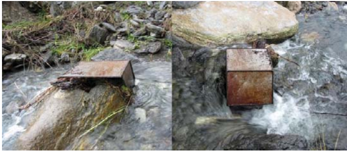
Abbildung B 2-2: Geschiebekorb alt (Oberlechner, 2015)
