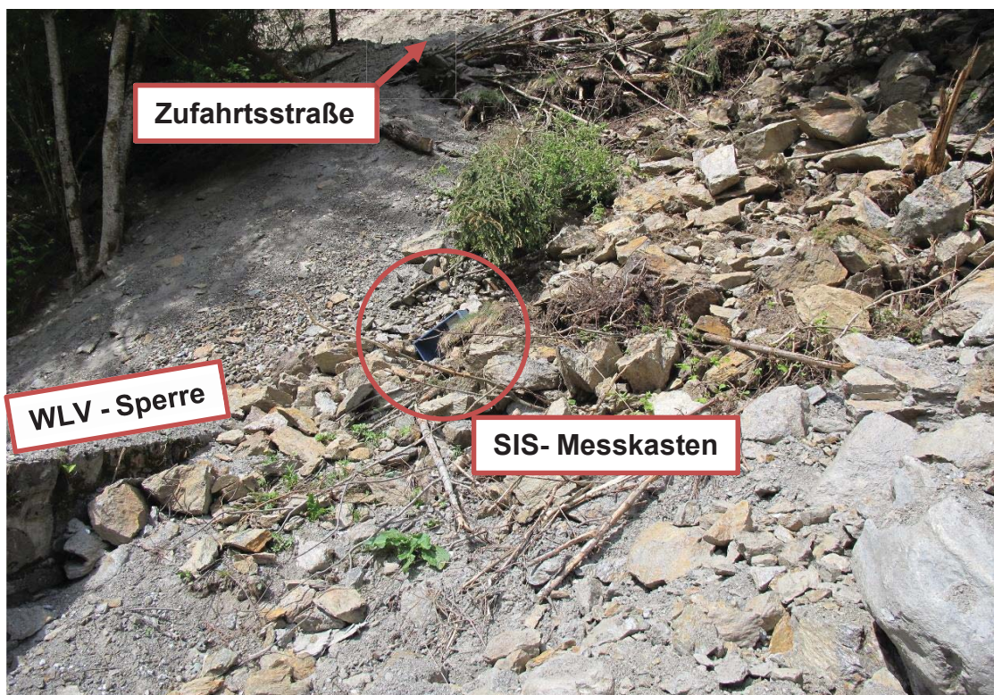
Abbildung B 2-6: SIS- Messstation zerstört
