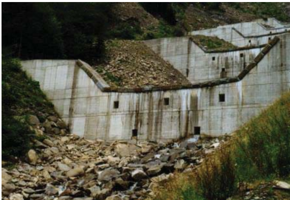
Abbildung A 2-9: Einfache Vollwandsperrern (links) Mehrfache Vollwandsperrern (rechts) (Hübl, et.al., 2003)
