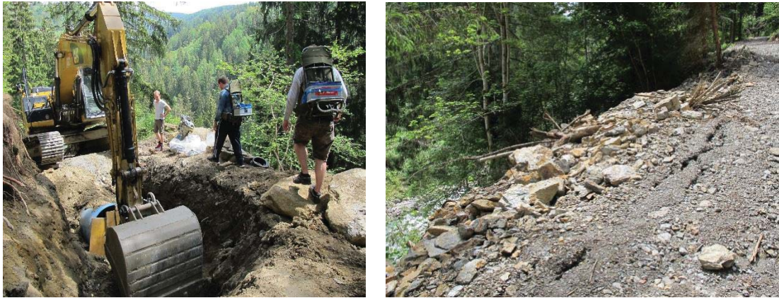
Abbildung B 2-7: Leitungsverlegung (links) Riss in der Zufahrtsstraße (rechts)
