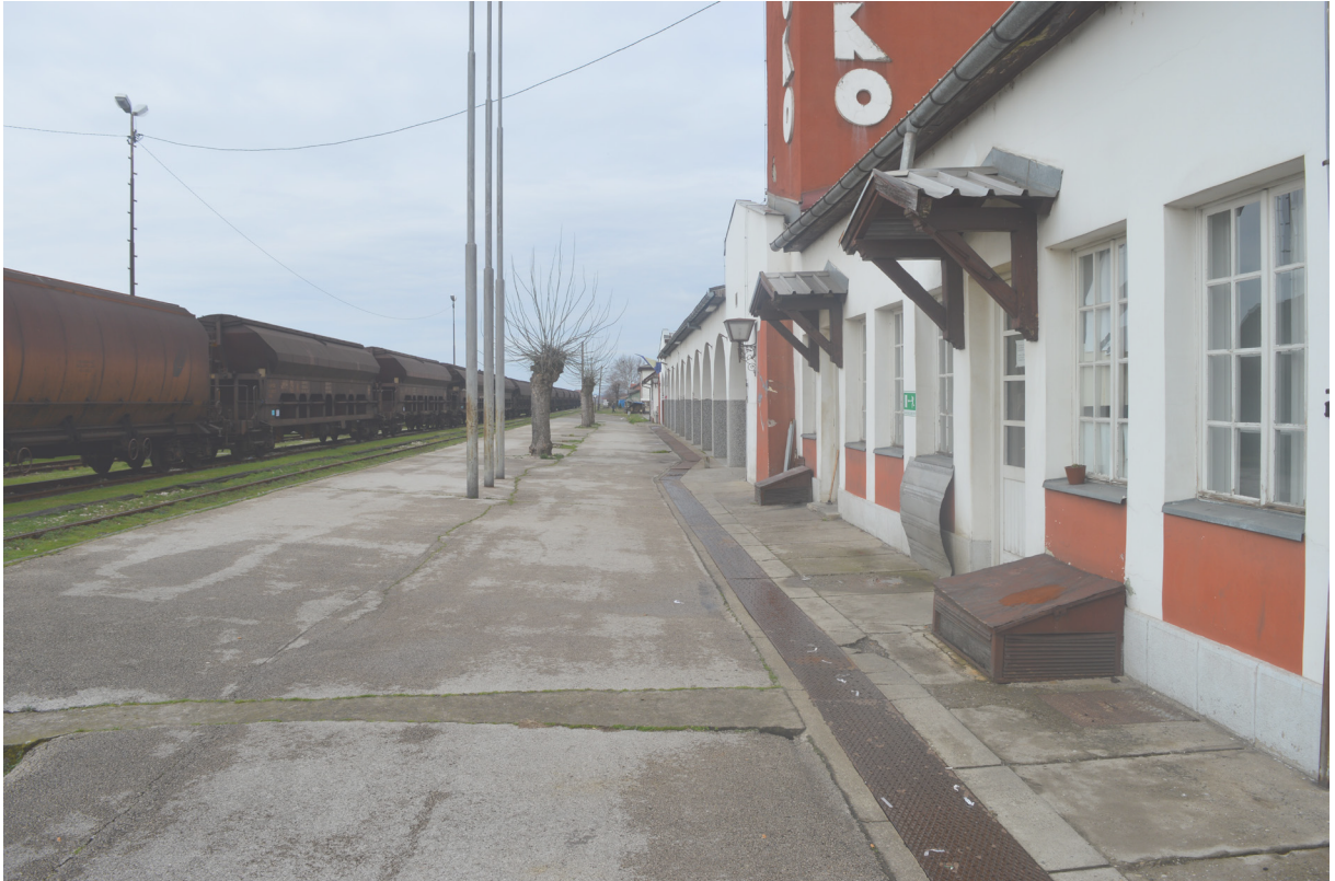
Abb. 72: Zugangsseite zu den Gleisen
