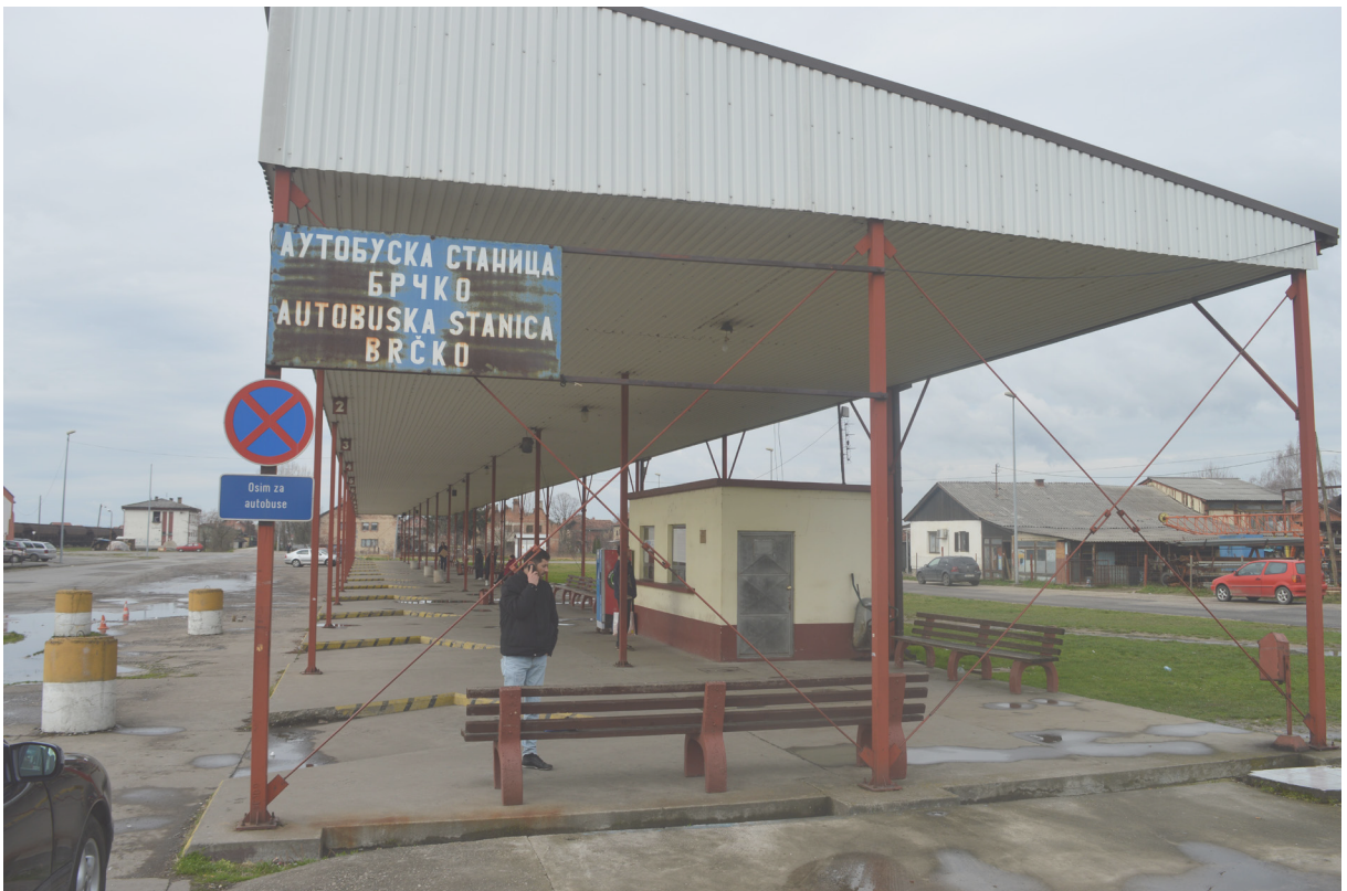
Abb. 77: Ticketschalter und Wartebereich des Busbahnhofs
