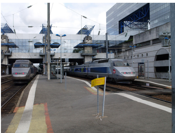
Abb. 82: Die Gleise mit einem TGV
