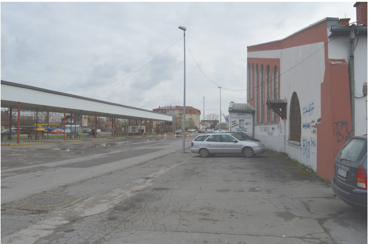
Abb. 71: Eingangsseite des Bahnhof und Busbahnhof
