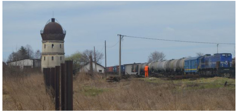
Abb. 28: Wasserturm am Bahnhofsgelände
