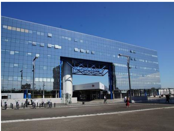
Abb. 80: Der Bahnhof von Rennes
