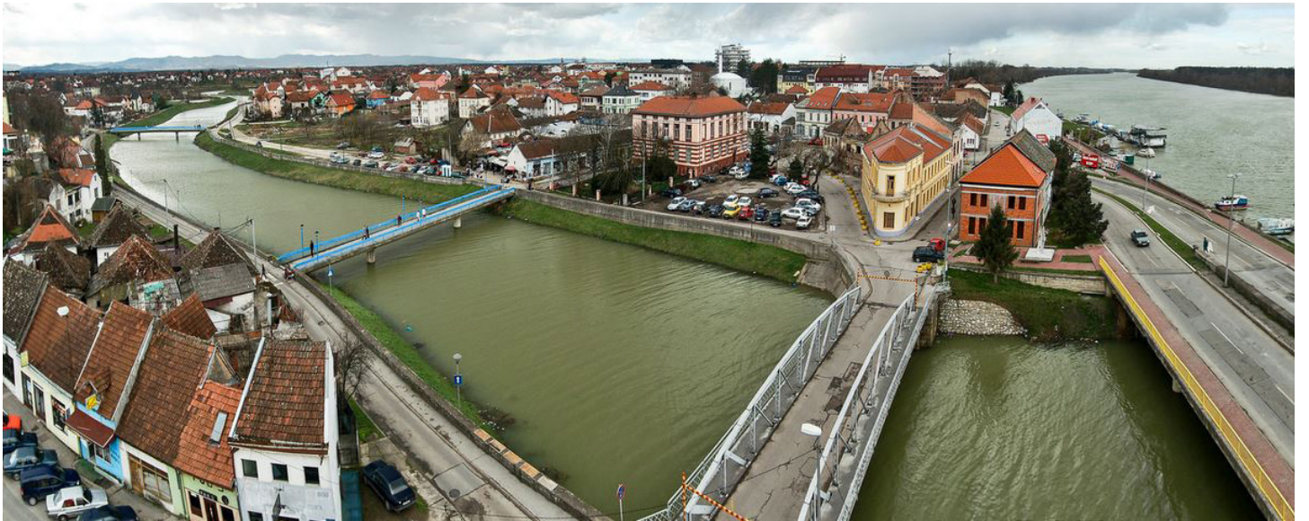
Abb. 06: Die Brücken von Brčko Distrikt
