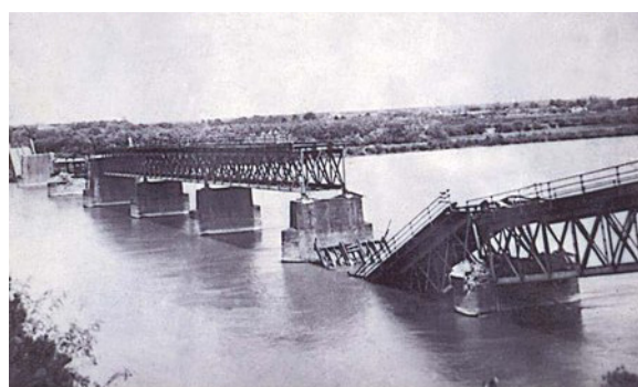
Abb. 36: Die zerstörte Save Brücke im April 1941
