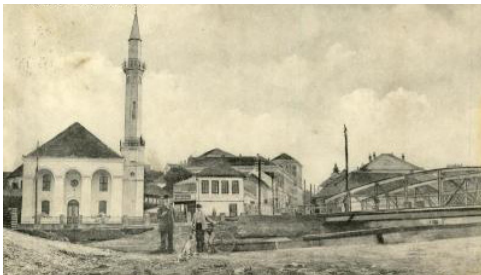
Abb. 07: Brücke an der Mündung Brka
