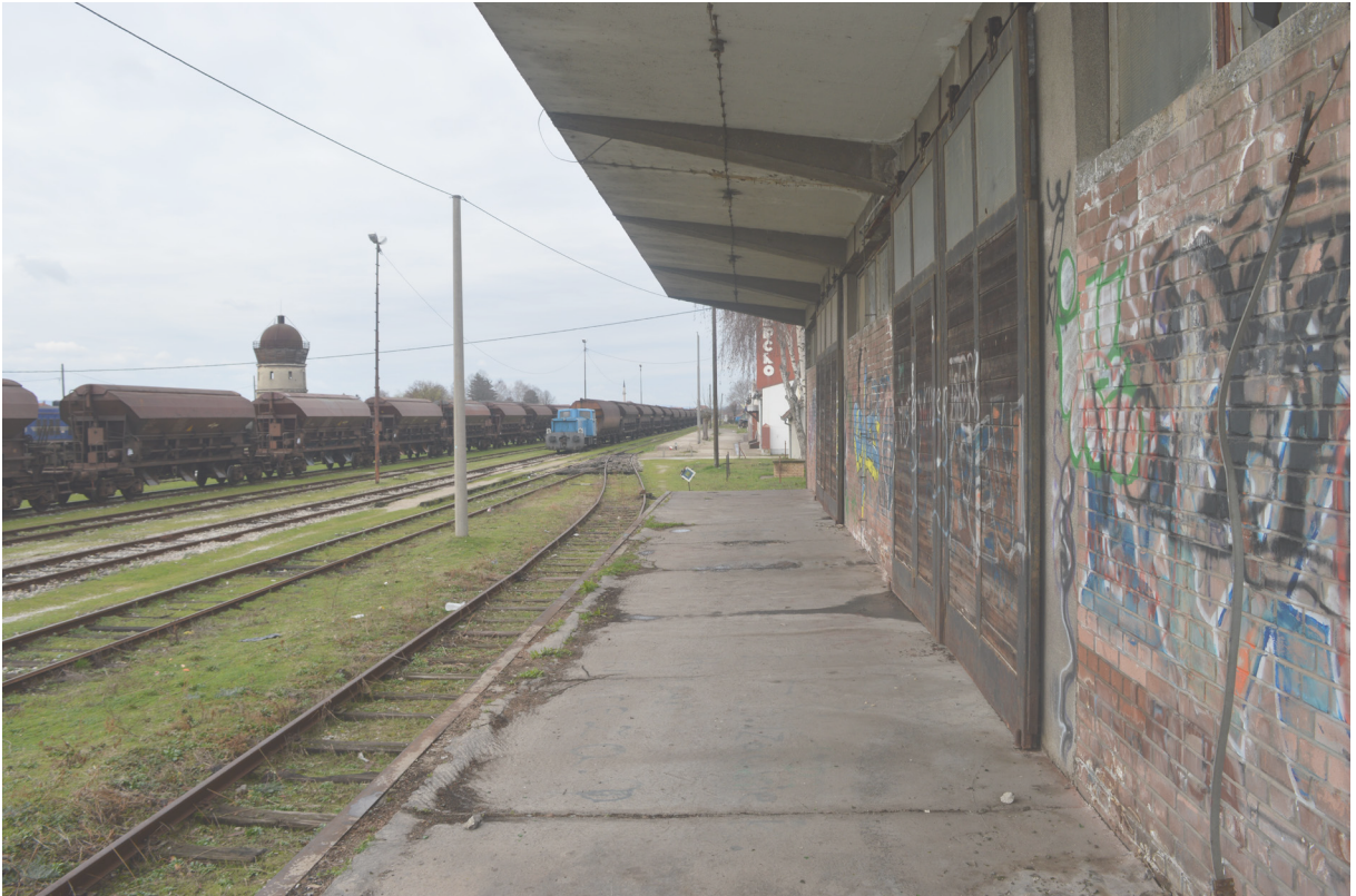
Abb. 68: Die Lagerhalle des Bahnhofs
