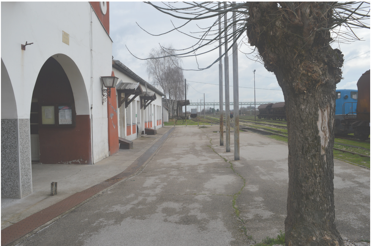
Abb. 75: Bahnhofszugang im Hintergrund die Brücke
