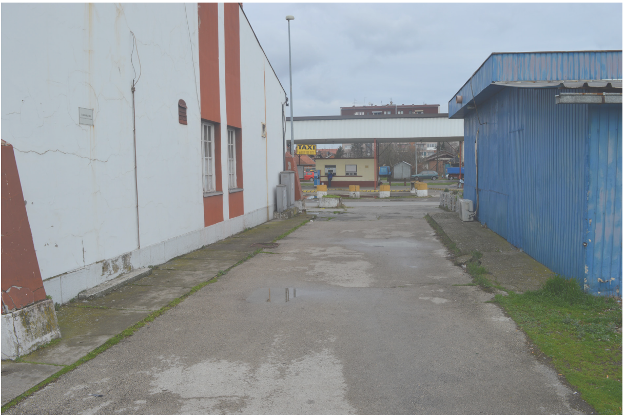
Abb. 69: Durchgang zwischen Bahnhof und Café
