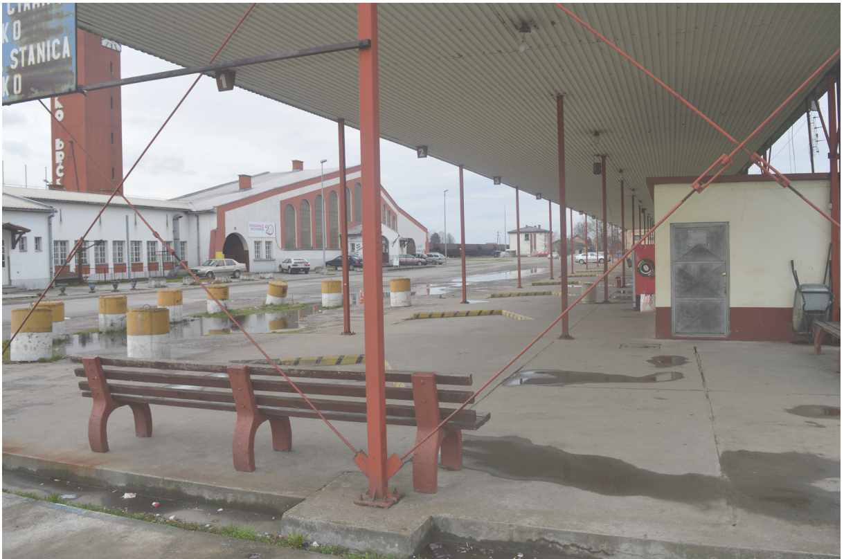
Abb. 78: Der Busbahnhof mit Blick auf den Bahnhof
