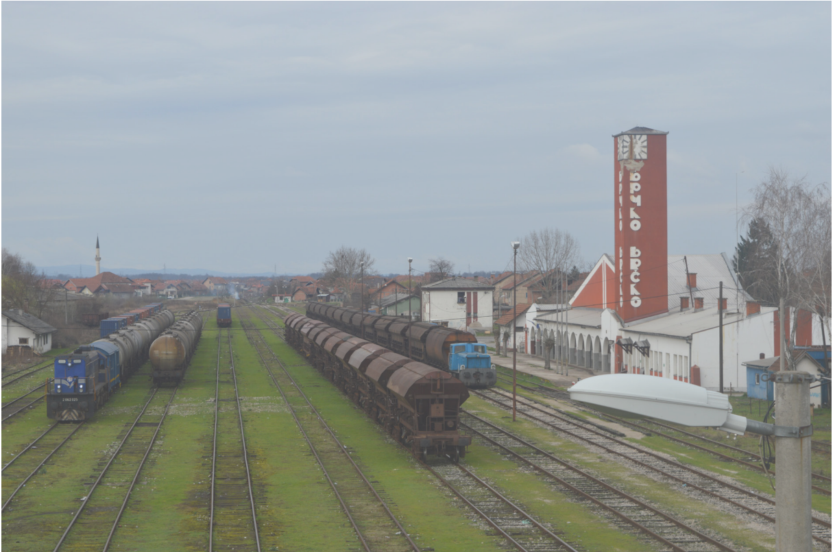
Abb. 70: Blick auf den Bahnhof von der Brücke
