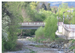
Abb. 40. Foto 7 - Brücke Packer Bundesstraße
