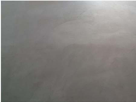
**Boden** geschliffener Estrich
