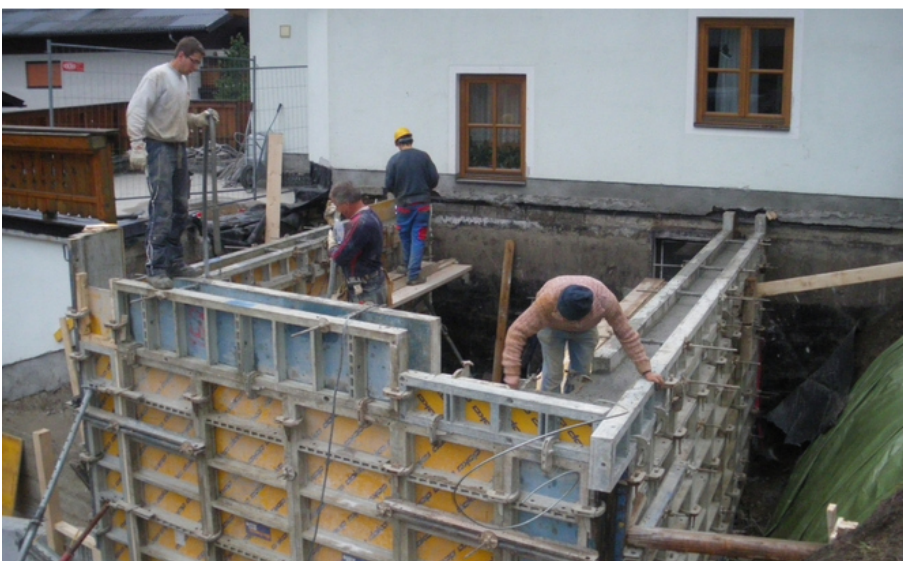
Abbildung 64: Ausführung einer Kellergeschoßerweiterung 90
