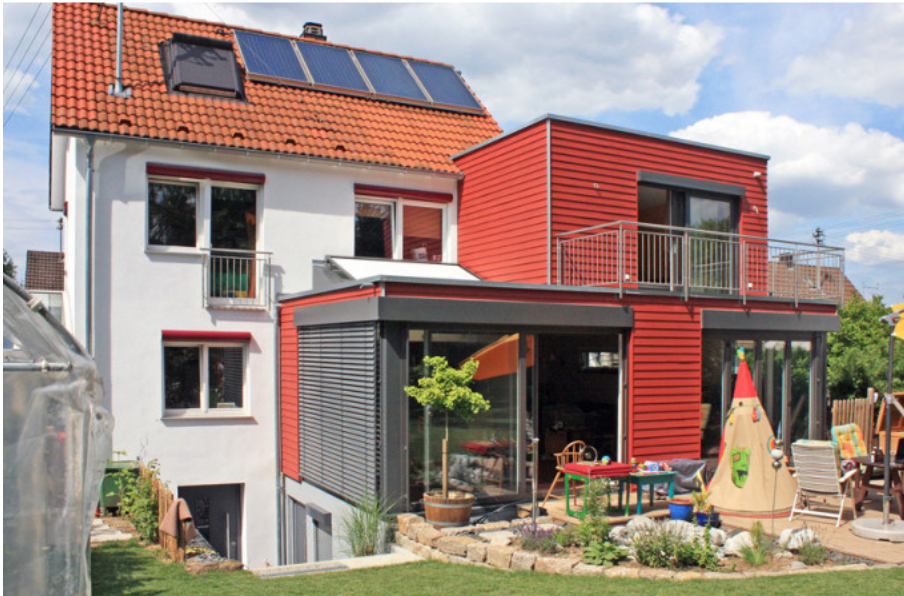
Abbildung 68: Ausführung einer Erdgeschoßerweiterung 91
