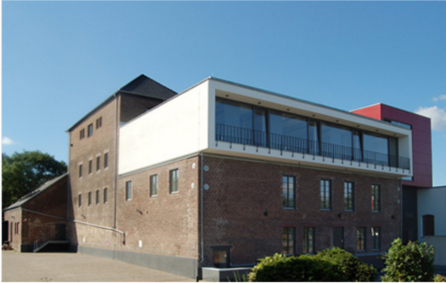
Abbildung 59: Ausführung einer Geschoßaufstockung 88
