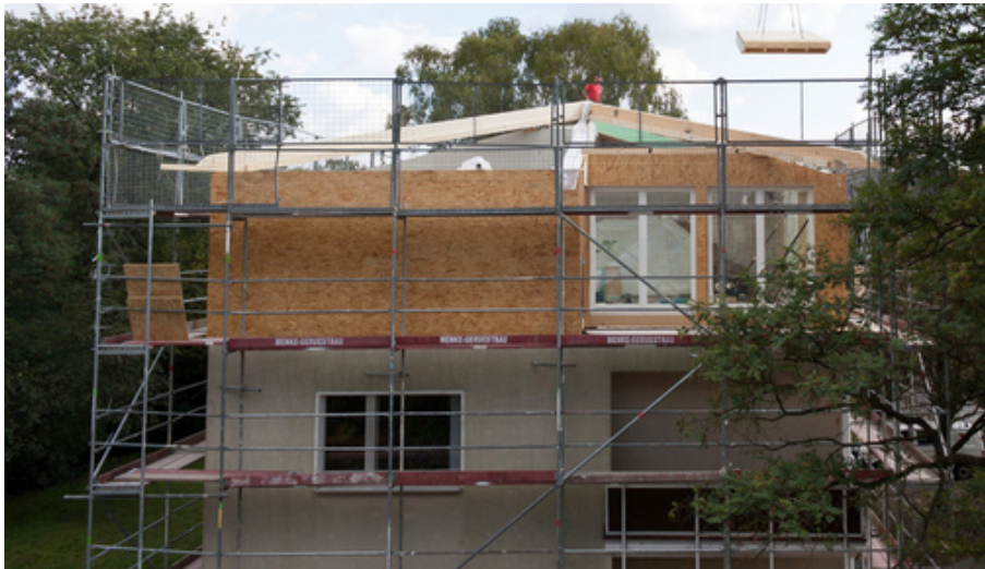
Abbildung 58: Ausführung einer Geschoßaufstockung 87
