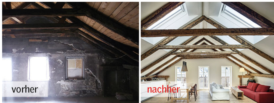
Abbildung 20: Revitalisierung eines unter Denkmalschutz stehenden Dachgeschoßes 38
