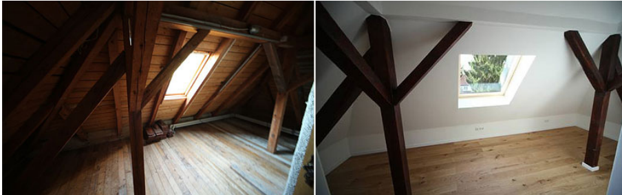
Abbildung 22: Ausbau eines Dachgeschoßes 42
