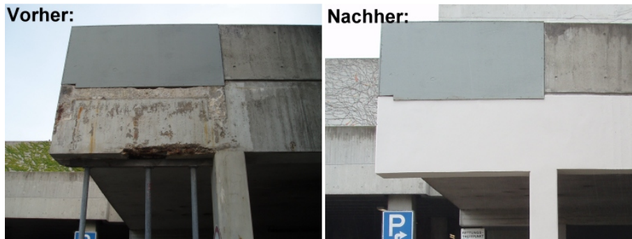
Abbildung 18: Sanierung eines Balkons 34
