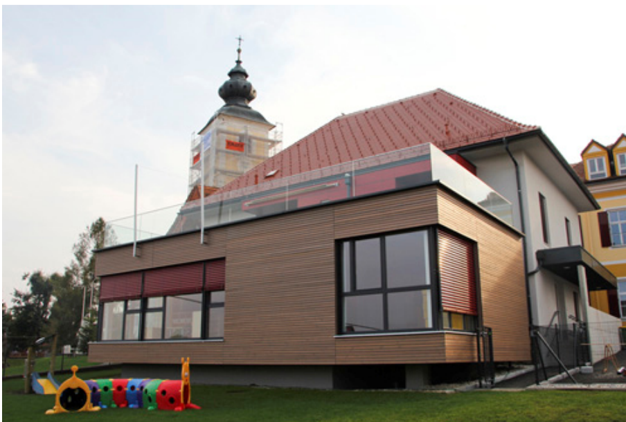
Abbildung 23: Zubau für einen Kindergarten 44
