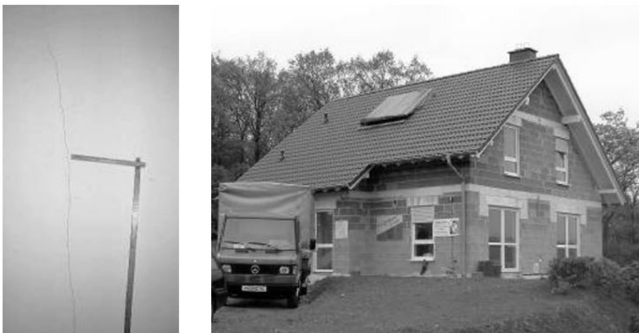
Abbildung 5: Beispiel für Schwinden 10
