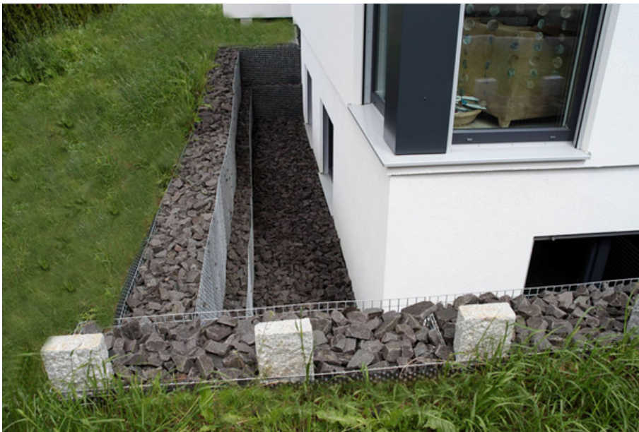
Abbildung 55: Ausführung eines Kellergeschoß Ausbaus 86
