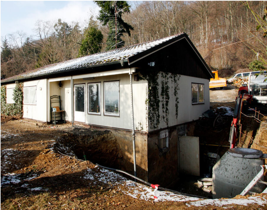
Abbildung 63: Ausführung einer Kellergeschoßerweiterung 89
