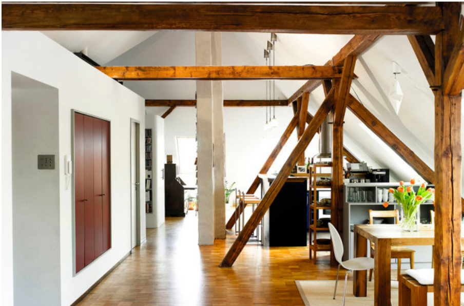
Abbildung 50: Ausführung eines Dachgeschoß Ausbaus 83
