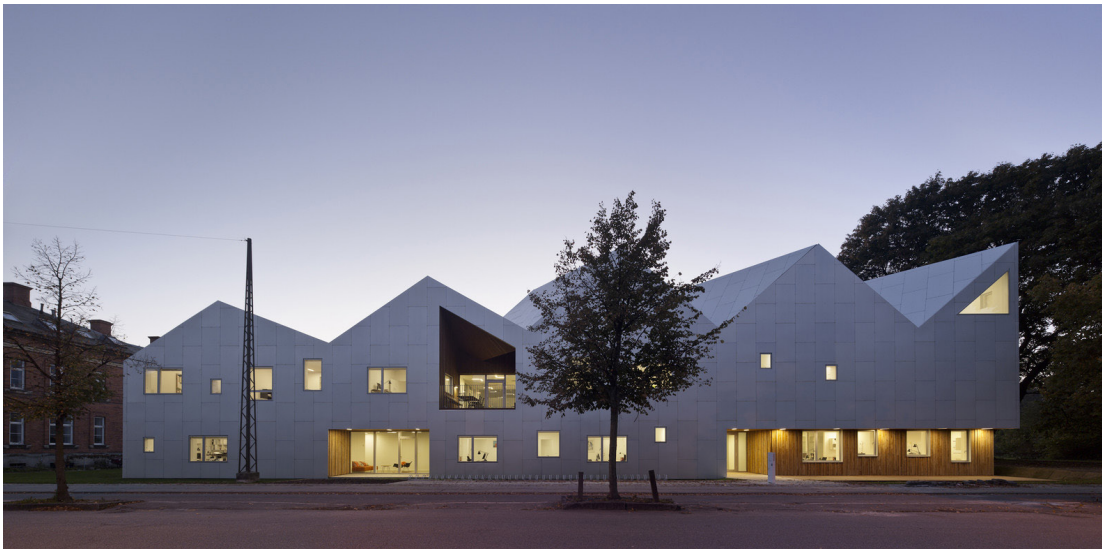
Abb. 12 NA_ Fassade straßenseitig
