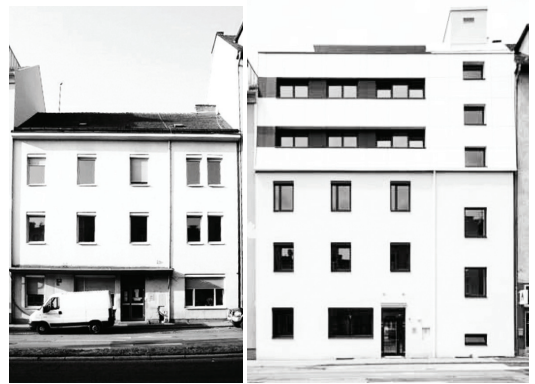
Abb. 4 Arche 38 - Vor und nach dem Umbau
