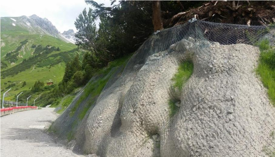
Bild 3.9: Hangvernetzung im Lastzustand<sup>22</sup>
