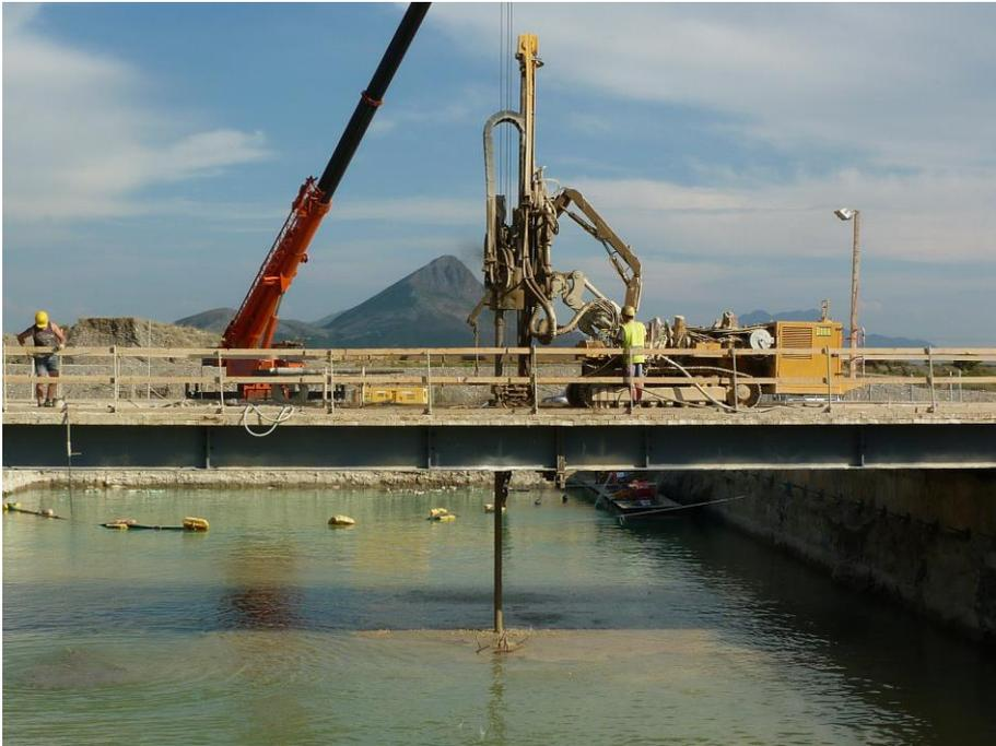
**Bild 3.4:** Bohrung zur Herstellung von GEWI - Pfählen<sup>13</sup>
