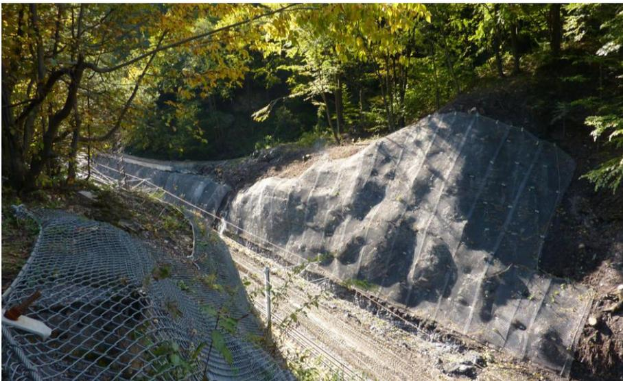
Bild 3.8: Hangvernetzung im fertigen Zustand<sup>21</sup>
