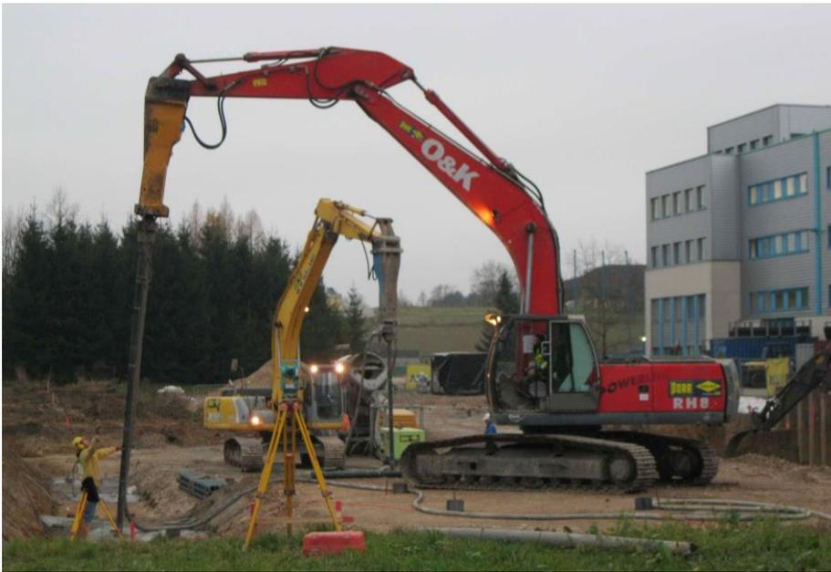
Bild 3.6: Herstellung eines Duktillpfahls<sup>15</sup>
