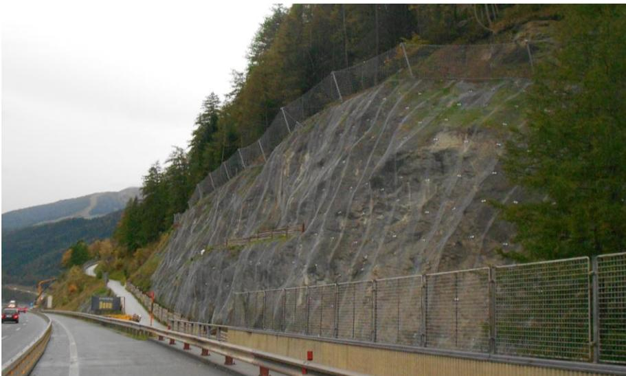
Bild 3.11: Hangvernetzung und Steinschlagschutz im fertigen Zustand<sup>24</sup>
