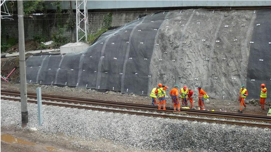
Bild 3.7: Hangvernetzung im fertigen Zustand<sup>20</sup>
