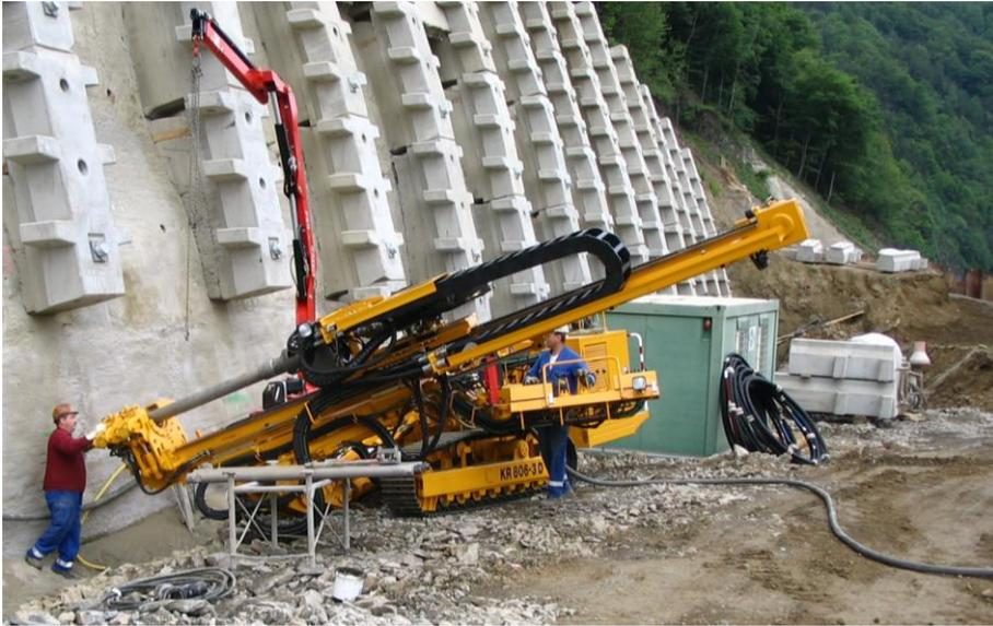
Bild 3.1: Bohrung zum Einbau von Freispiellitzenanker<sup>9</sup>
