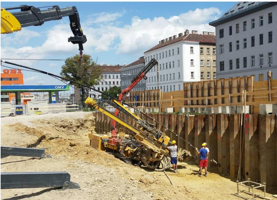
Bild 3.2: Einbringen eines Stabankers<sup>10</sup>
