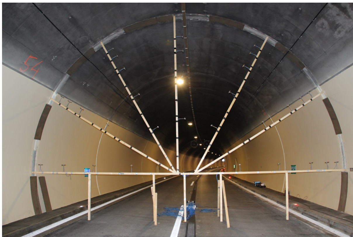
Abbildung 2-7: Ansicht des aufgebauten Messnetzes, Tunnel Falkenberg
