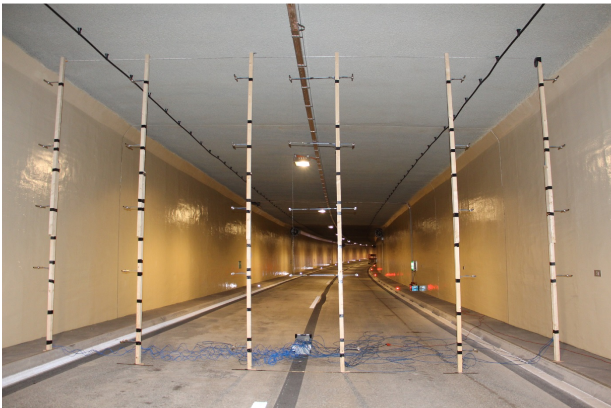
Abbildung 2-3: Ansicht des aufgebauten Messnetzes, UFT Lendorf
