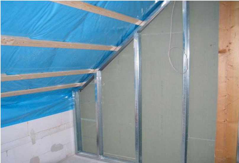
Abbildung 36: Links: Unterkonstruktion aus Holz für die Trockenbauplatten. In Blau ist die Dampfbremse ersichtlich. Rechts: Ständerkonstruktion in Aluminium 111
