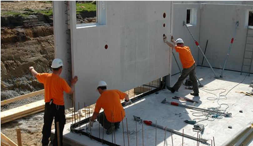
Abbildung 34: Hohlwand während des Versetzvorganges 98
