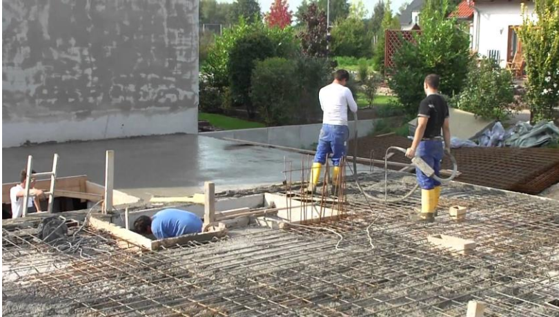
Abbildung 41: Plattendecke während des Betoniervorgangs. Gut ersichtlich sind die obere Bewehrungslage und Aussparungen der Decke 116
