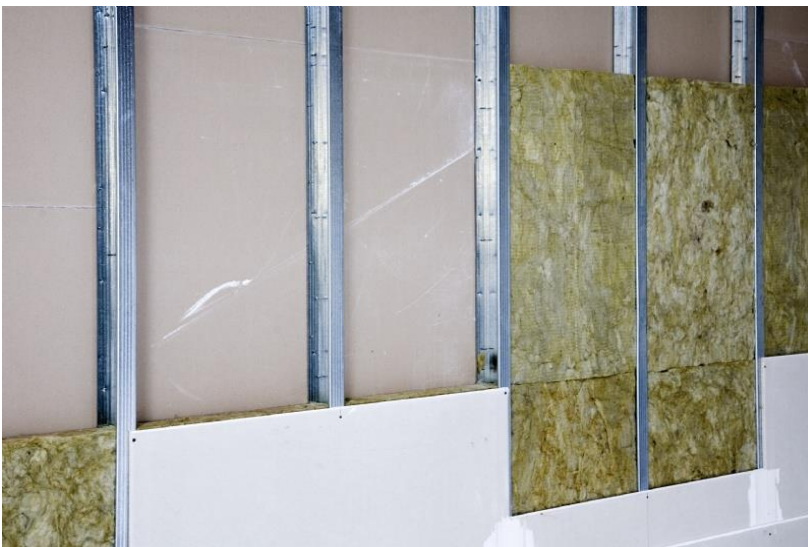
Abbildung 37: Trockenbauweise mit einer Alu-Ständerkonstruktion und zwischenliegender Dämmung 112
