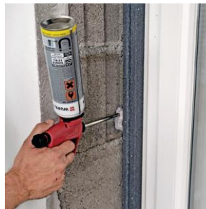
Abbildung 61: Links: Vorkomprimiertes Dichtungsband wird um den Fensterstock geklebt, welcher daraufhin in der Fensteröffnung fixiert wird 171 . Rechts: Ausfüllen der Fuge mittels Fenster-Montageschaum 172
