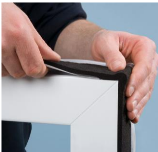
Abbildung 61: Links: Vorkomprimiertes Dichtungsband wird um den Fensterstock geklebt, welcher daraufhin in der Fensteröffnung fixiert wird 171 . Rechts: Ausfüllen der Fuge mittels Fenster-Montageschaum 172
