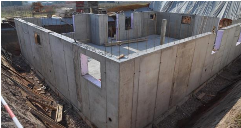
Abbildung 35: Ausgeschalteter Keller in Ortbetonbauweise 108
