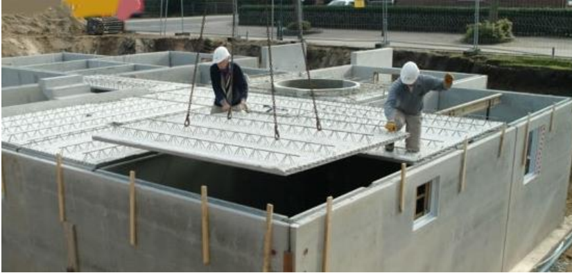
Abbildung 43: Elementdecke bei der Verlegung auf Hohlwänden 119
