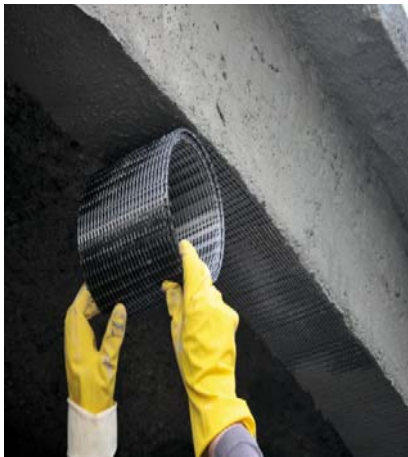
Abb. 3.1 Verstärkung Unterzug mittels Karbongelege[60]
