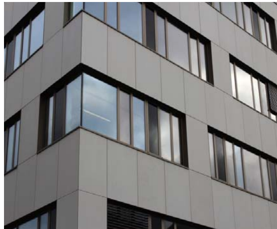
Abb. 3.2 Fasadenelemente aus Textilbeton Stärke 2 cm [59]
