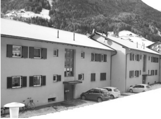
Abb.86: Erste vom WOBI errichtete Wohnhaus
