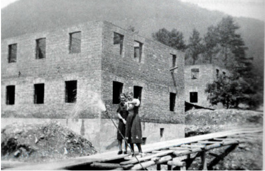
Abb.74: Häuser ohne Dachstuhl
