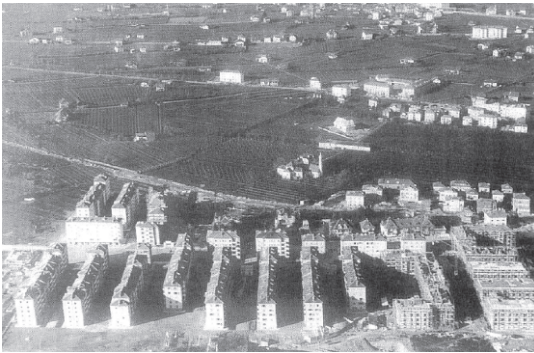
Abb.24: Bau des Rione Littorio im Jahre 1938
