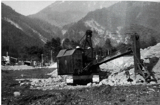
Abb.73: Anfang der Arbeiten
