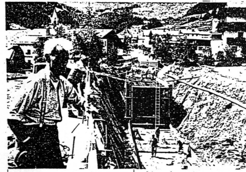
Ein Bild aus den unruhigen Jahren 1984 und 1985: Die Dorf-U-Bahn wird gebaut
