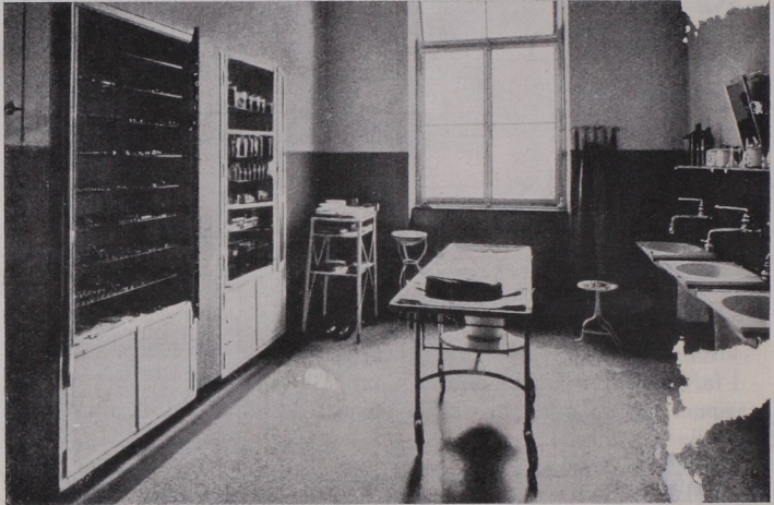
Abb. 52. Hagen i. W., Allgem. Krankenhaus. Vorbereitungszimmer.
