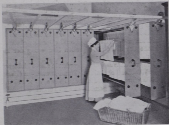
Abb. 100. Karlsruhe, Ludwig-Wilhelm-Krankenhaus, Kulissenschrank.
