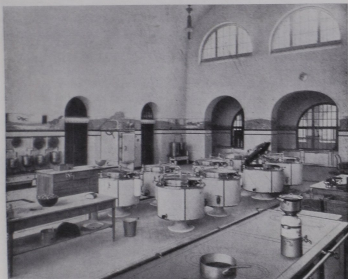
Abb. 90. Leipzig-Eutritzsch, städt. Krankenhaus St. Georg, Kochküche.
