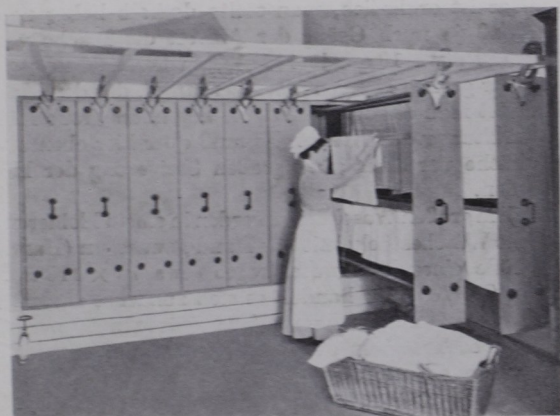
Abb. 100. Karlsruhe, Ludwig-Wilhelm-Krankenhaus, Kulissenschrank.
