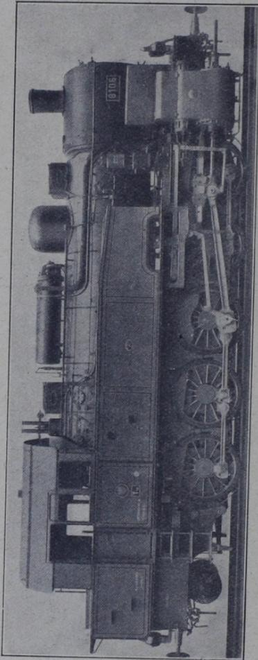
Abb. 429. E-Heißdampf-Zwilling-G-Tenderlokomotive Gattung  $T_{16}$  (Preußen).
