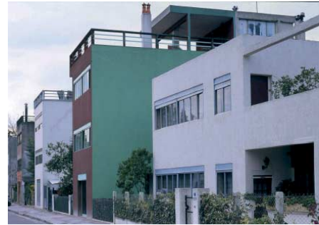
FIG. 13 The Pessac-colony today [Source: Fondation Le Corbusier].
