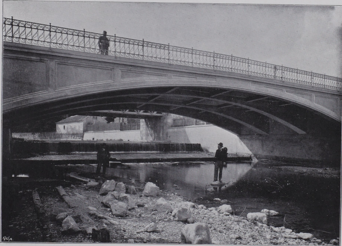
12,0 m breit, 23,7 m Spannweite, gerechnet für 12 tons-Wagen. Konstruiert mit Vermeidung jedweder toten Last. Brücke und Widerlager aus armiertem Beton.
