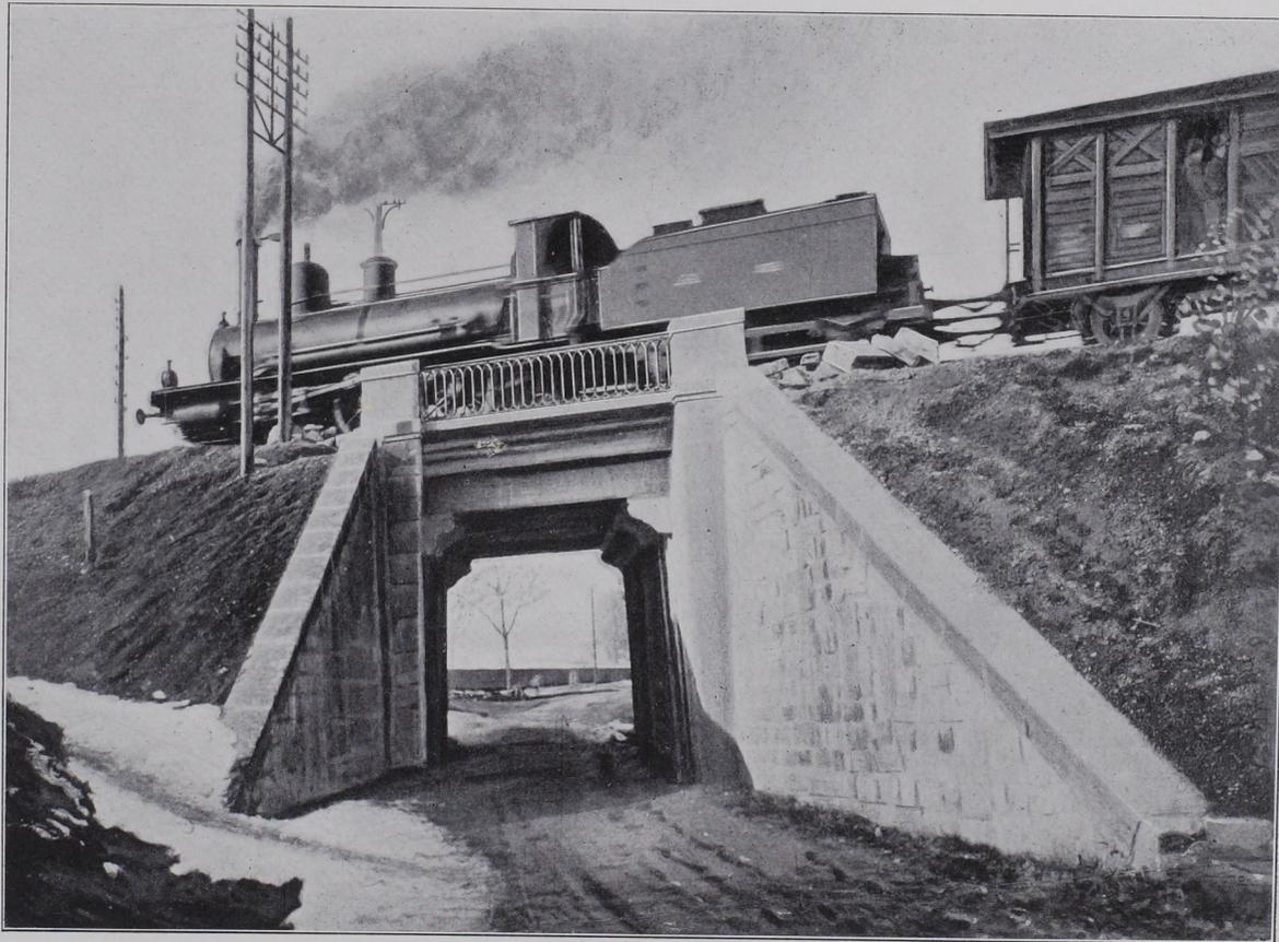
Ausgeführt im Jahre 1897. Spannweite 4,25 m. Lokomotiven von 47,5 t.
