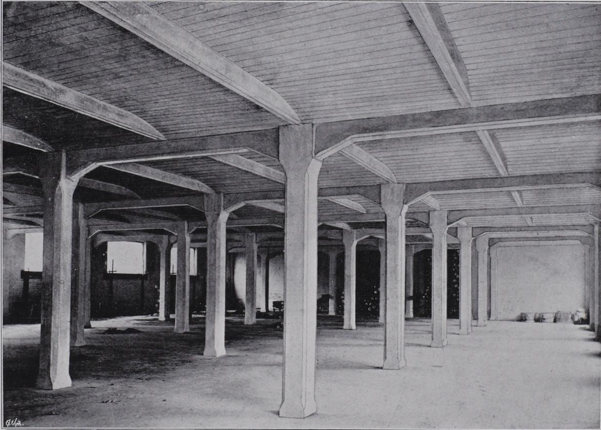
Ausgeführt in armiertem Beton.
