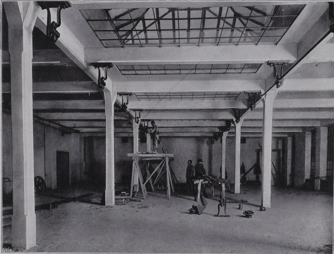
Decken und Säulen aus armiertem Beton System Ast & Co. (verbessertes System Hennebique).
