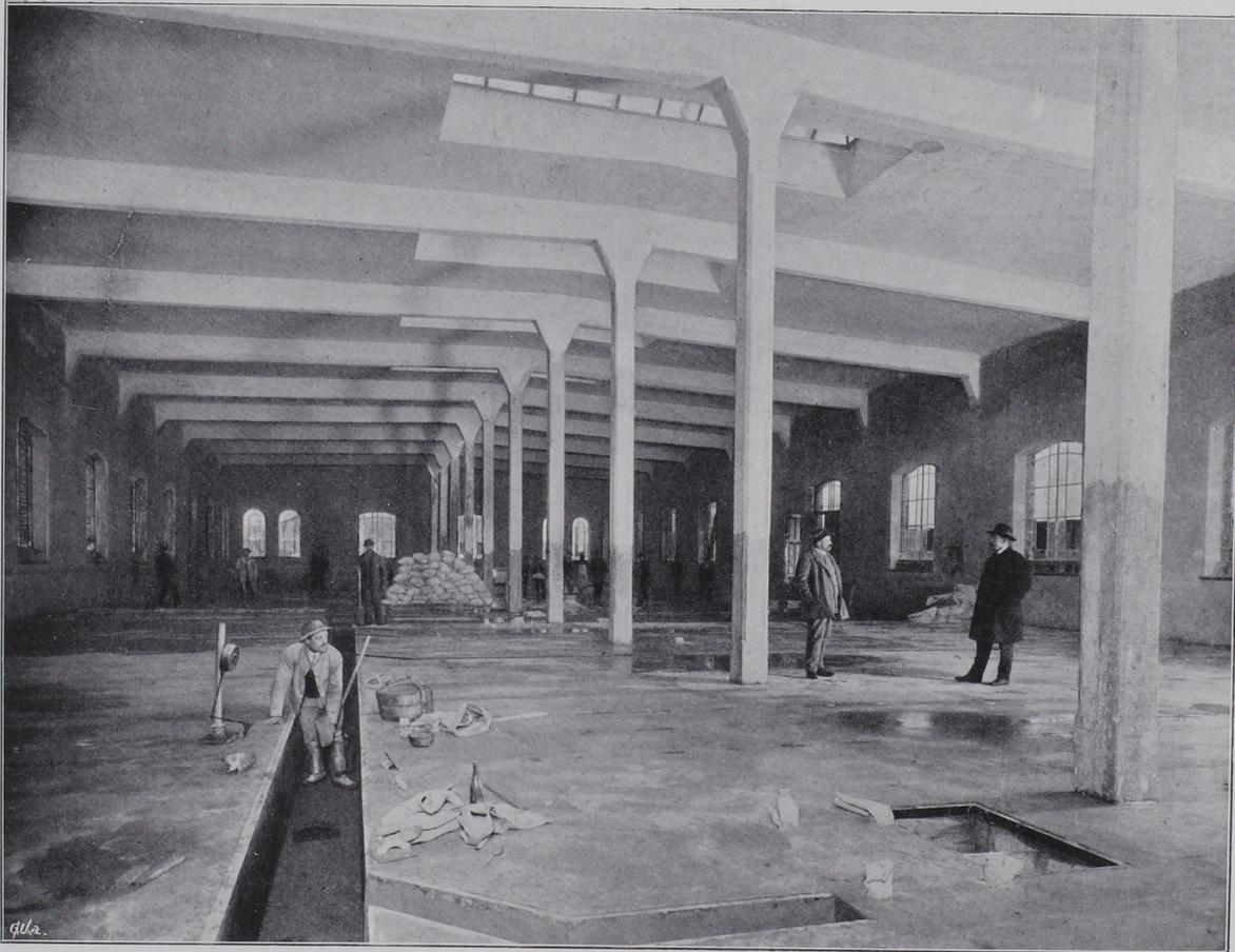
Sheddach mit Oberlichten ganz in armiertem Beton System Ast & Co. (verbessertes System Hennebique).
