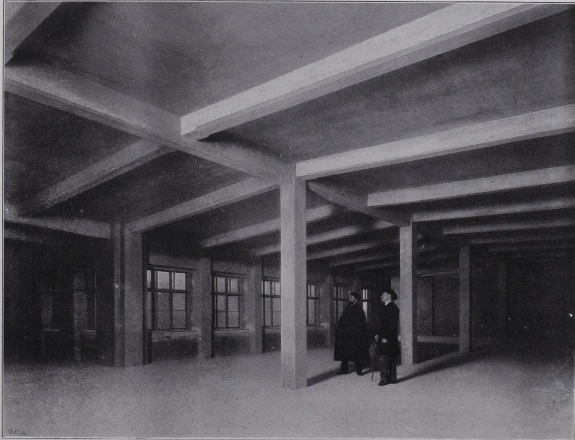
Dachgeschoss des Magazinsgebäudes. Decken, Säulen und Fensterüberlagen aus armiertem Beton.
