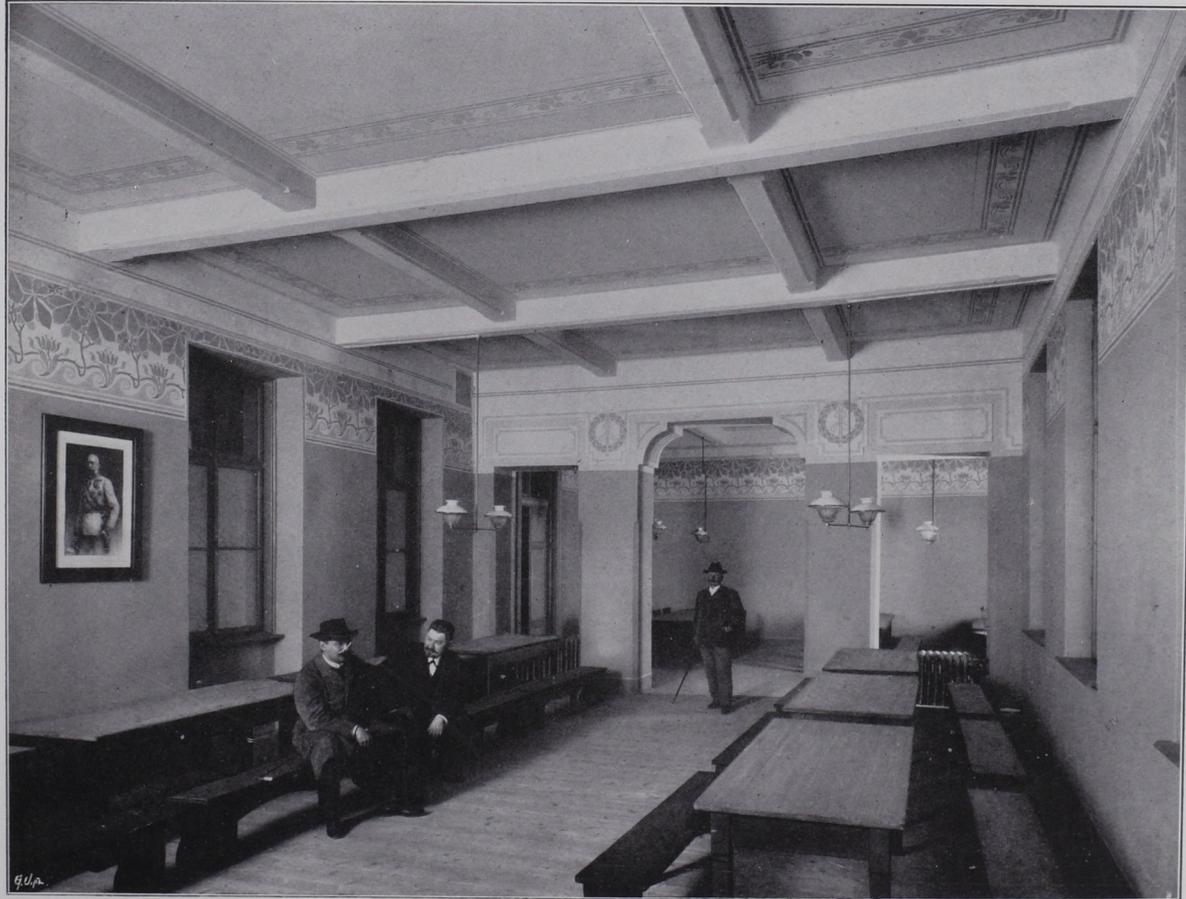
Sämtliche Decken und Stiegen in armiertem Beton. Gesamtausmass 10.000 m<sup>2</sup>.
