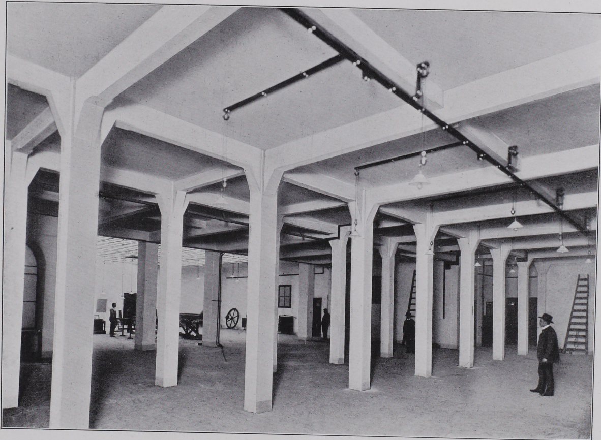
Ausgeführt im Auftrage der Herren Architekten Kupka & Orgelmeister in Wien (anno 1900). Decken und Säulen in armiertem Beton, gerechnet für eine Nutzlast von 1000 kg per m^2 .
