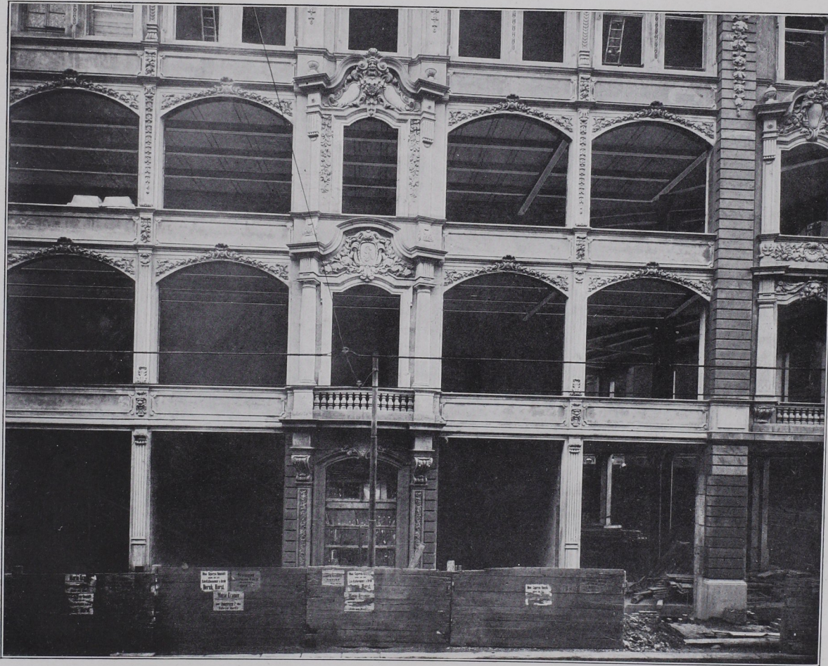
Die ganze, auf dem Bilde sichtbare Tragkonstruktion, als: Säulen, Fensterstürze und Decken sind in armiertem Beton. Belastung 1000 kg per m^2 .
