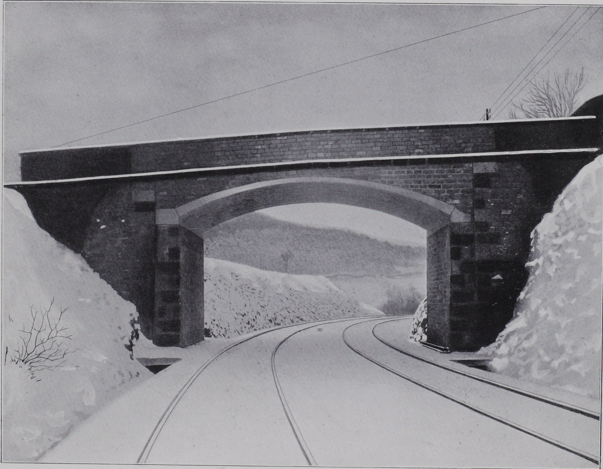
Ausgeführt im Zuge der Bielatalbahn der Aussig-Teplitzer Eisenbahngesellschaft in der Nähe von Hostomitz in Böhmen im Auftrage des Herrn Bauunternehmers Ingenieur Marek (1899).
