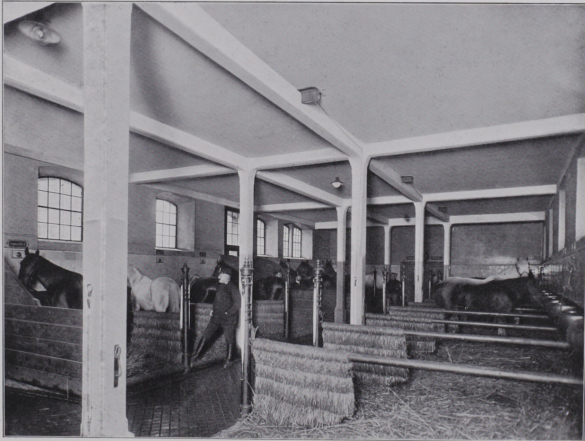
Decken und Säulen in armiertem Beton. Ausgeführt im Auftrage der k. k. Dikasterialgebäudedirektion in Wien (anno 1900). Diese Decke ist durch 30 cm starke Abteilungsmauern belastet.
