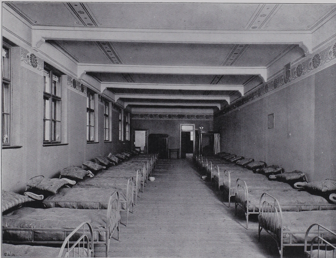
Sämtliche Decken- und Stiegenkonstruktionen in armiertem Beton. Gesamtausmass 10.000 m 2 .
