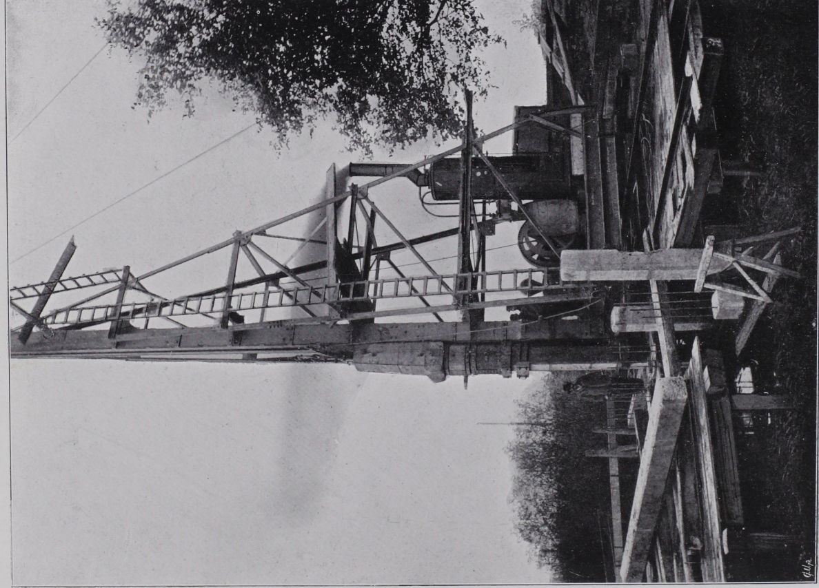
Höhe der Kamme 15.00 m, Gewicht des Rambahären 4000 kg, Länge der Piloten 8.9 m, Querschnitt 30/30 cm.
