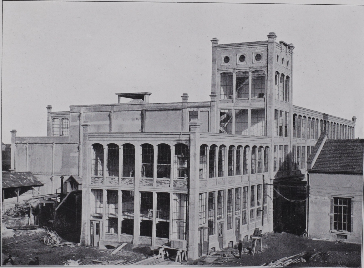
Wände, Säulen, Decken — alles in armiertem Beton. Putz als überflüssig weggelassen. Summe der Bauarbeiten 300.000 Mark.
