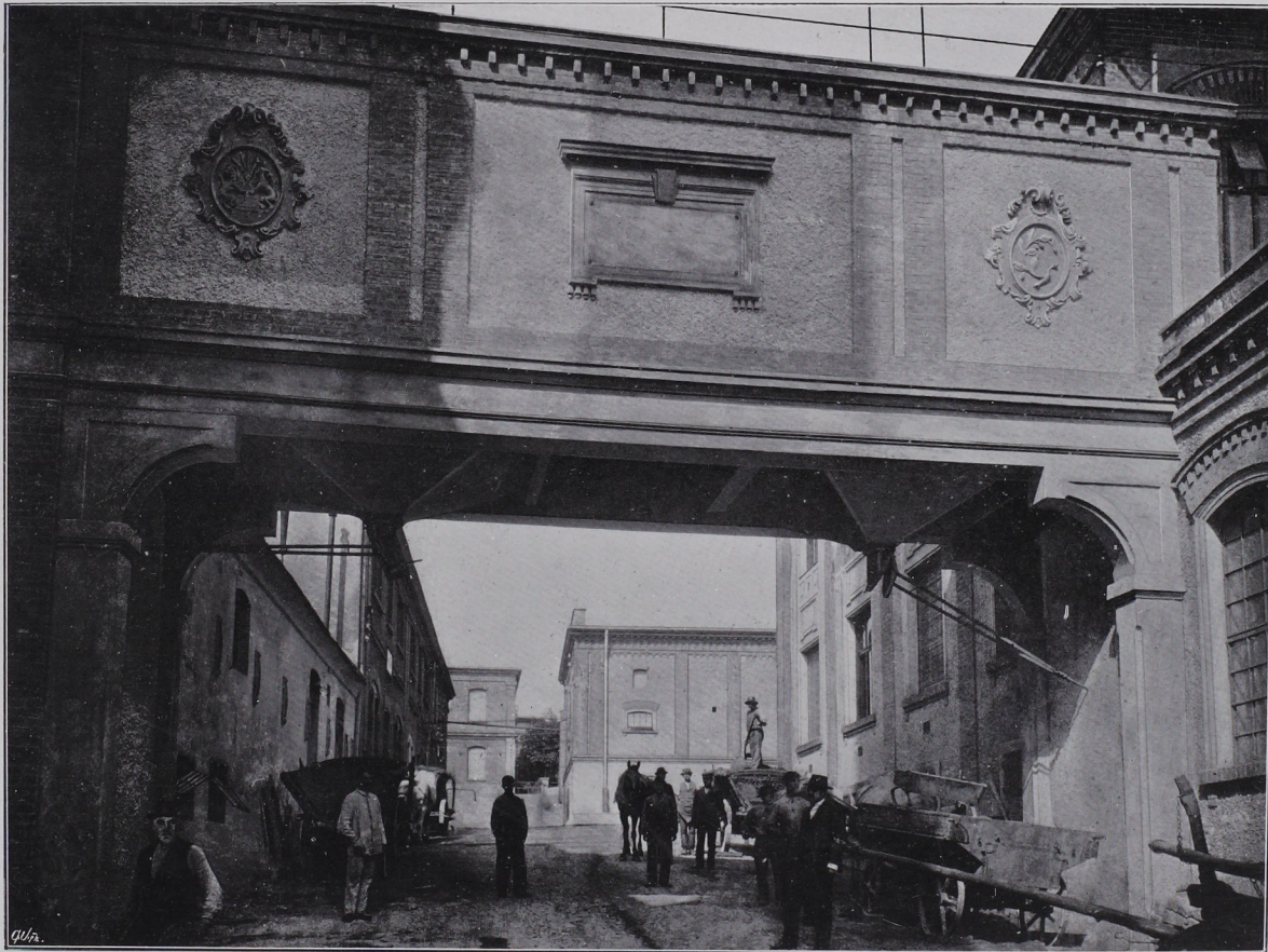
Ausgeführt im Auftrage der Herren Medinger & Bachofen ganz in armiertem Beton.
