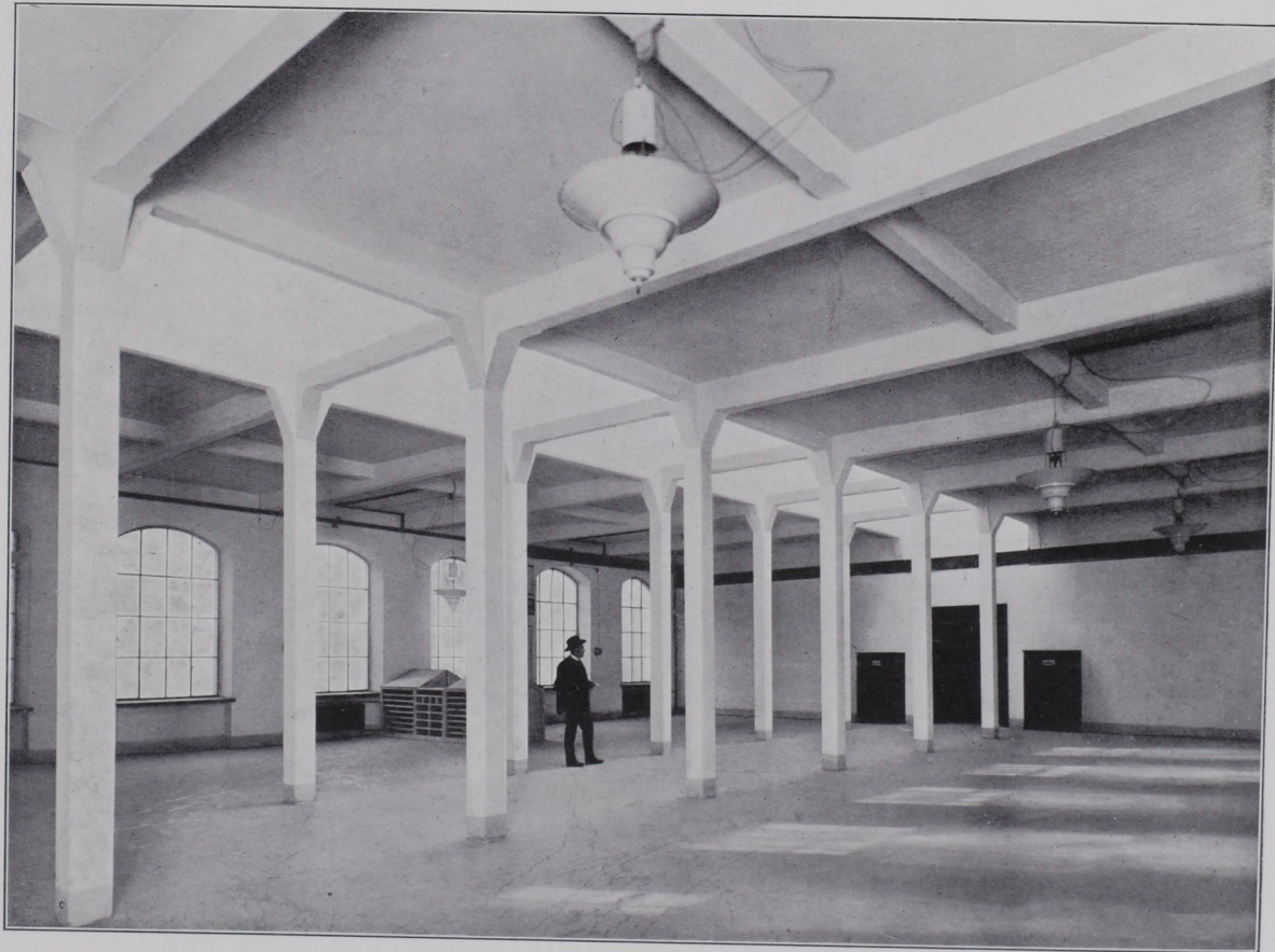
Ausgeführt im Auftrage der Herren Architekten Kupka & Orgelmeister in Wien (anno 1900). Decken und Säulen in armiertem Beton, gerechnet für eine Nutzlast von 1000 kg per m^2 .
