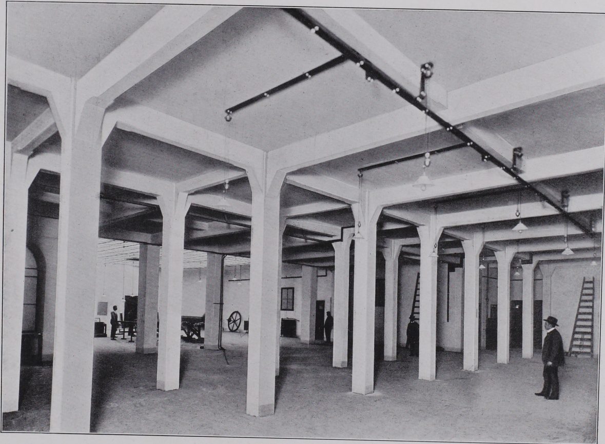
Ausgeführt im Auftrage der Herren Architekten Kupka & Orgelmeister in Wien (anno 1900). Decken und Säulen in armiertem Beton, gerechnet für eine Nutzlast von 1000 kg per m^2 .
