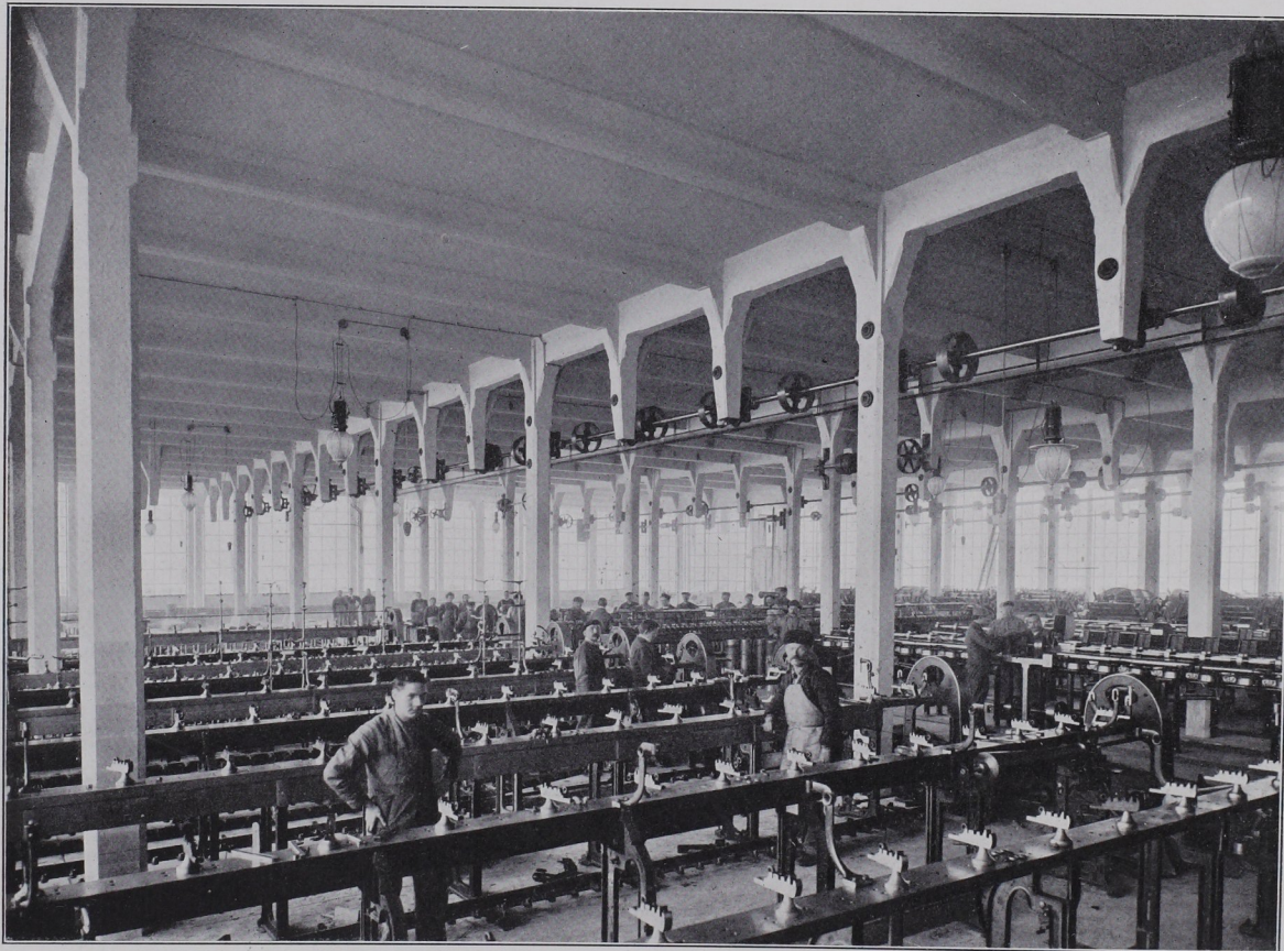
Wände, Säulen, Decken — alles in armiertem Beton. Bausumme 300.000 Mark.
