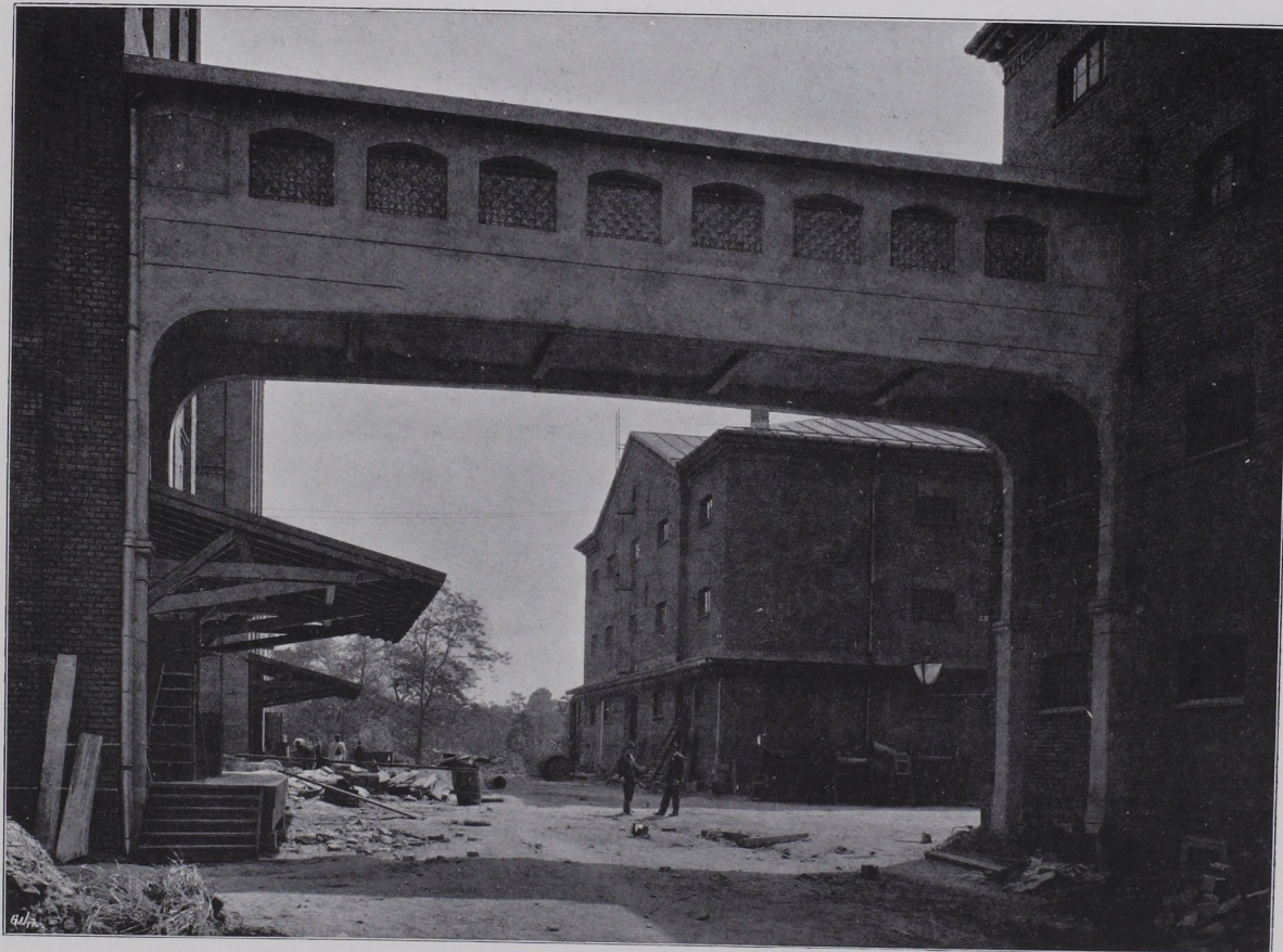
Die ganze Brücke, Wände, Säulen und Dach aus armiertem Beton. Spannweite 16 m, Nutzlast 800 kg per m^2 . Höhe über dem Boden 10 m.
