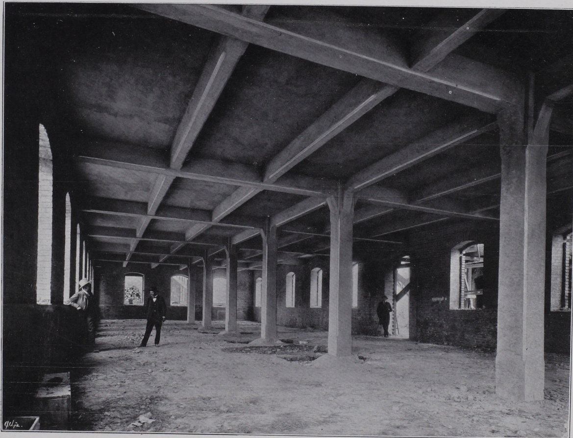
Sämtliche Decken, Säulen und Dächer in armiertem Beton System Ast & Co. Nutzlast 1000 kg per m^2 .
