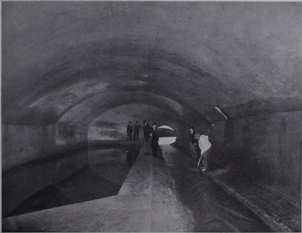
Schotterfang im Zuge des rechtsseitigen Wiener Hauptsammelkanales an der Ecke Schottenring und Franz Josefs-Quai.
