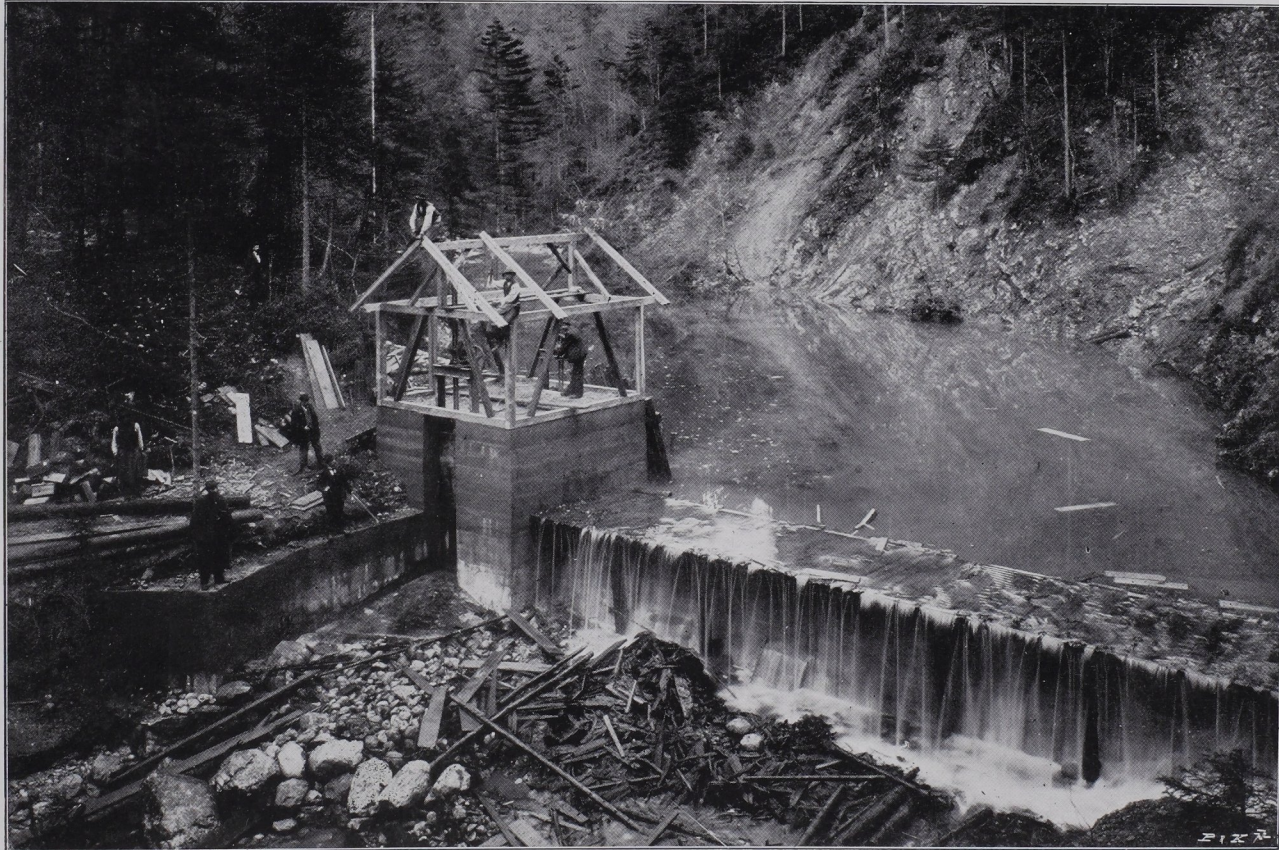
Die ganze Anlage erbaut von Ed. Ast & Co. im Jahre 1898.
