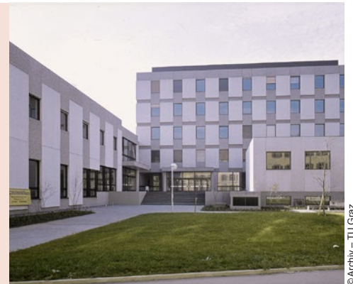
Das Physikgebäude in der Petersgasse knapp vor seiner Vollendung.
