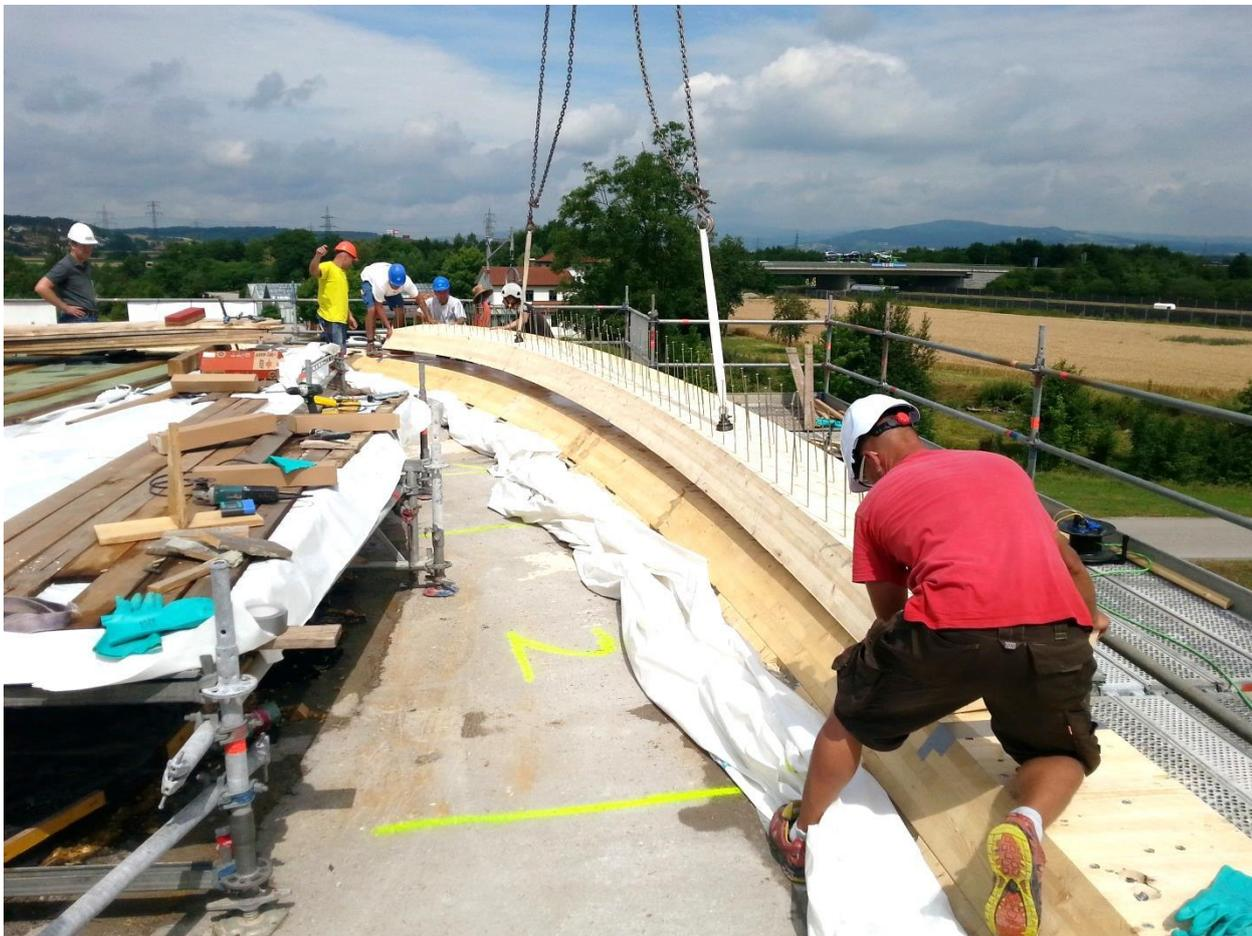
*Abbildung 4: baustellenseitige Verschraubung von BSP-Elementen, [58]*
