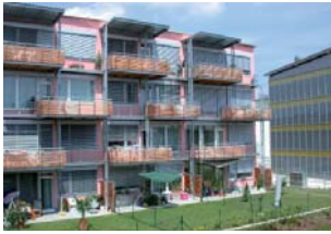
Abb. 9: Wohnhausanlage mit Passivhaus | Treberspurg + Partner Architekten
