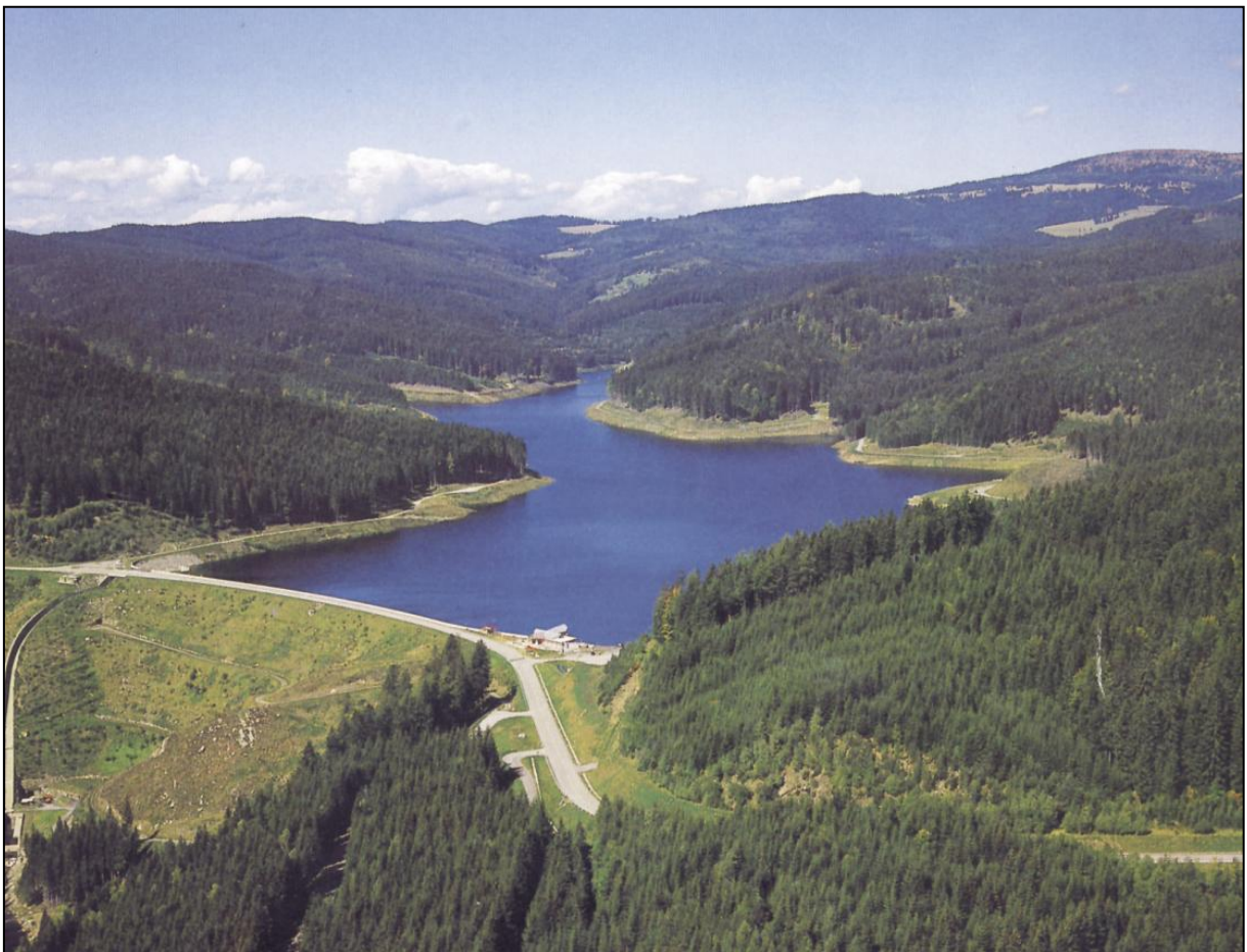
Abbildung 36: Wasserspeicher der Anlage
