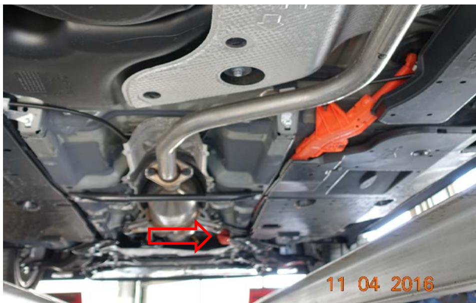
Abbildung 3-20: Verlauf der Hochvoltleitungen unterhalb des Toyota Auris Hybrid
