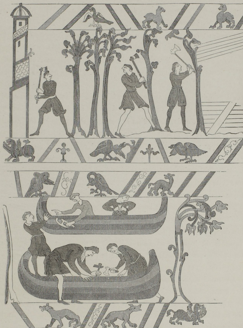
Fig. 27. — Fragment de la Tapissérie de Bayeux , lequel représente la construction des nefs du duc Guillaume (avec la bordure).
