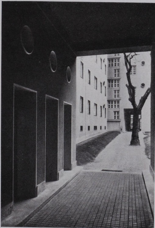
Vorhaus mit Blick in den Hof
