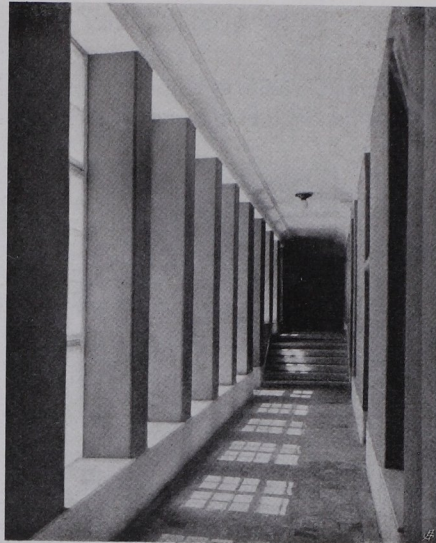
Korridor im Erdgeschoß zu den Stiegen
