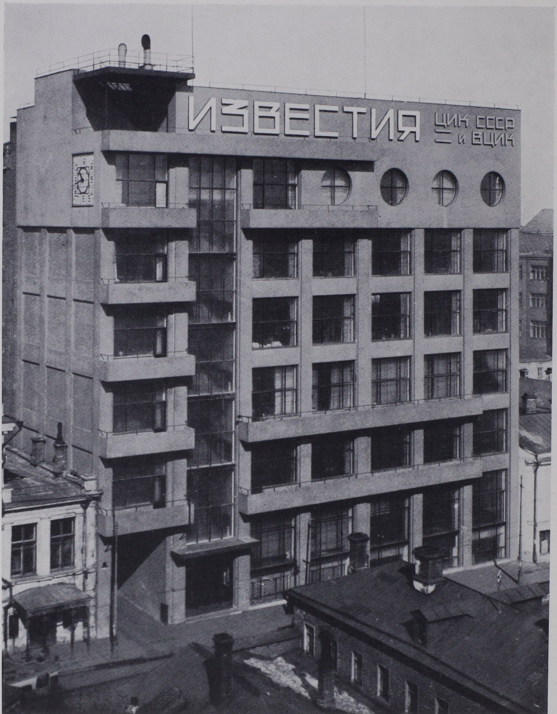
Abb. 78. G. Barchin. „Izvestia“-Bau.
