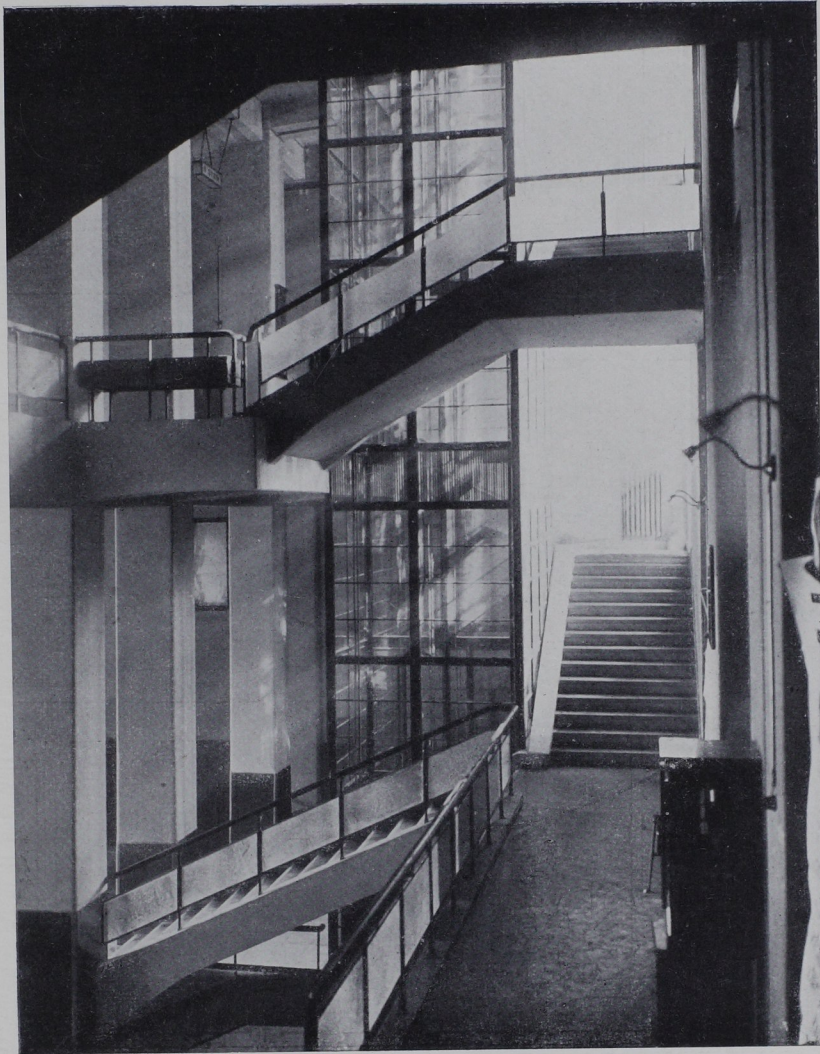
Abb. 75. B. Welikowski. Treppenhaus im Gostorg.
