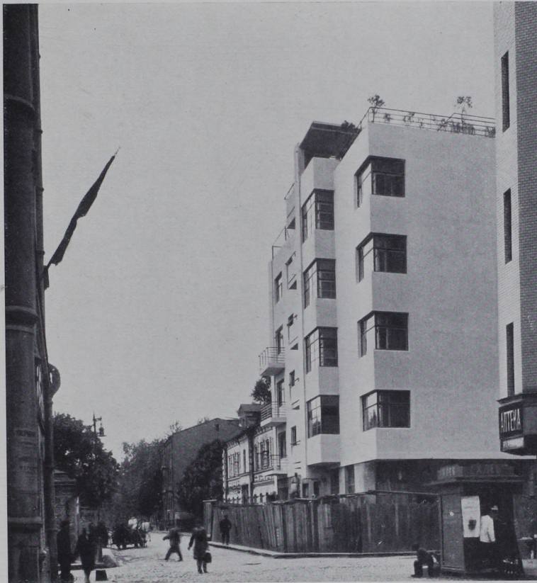
Abb. 53. M. Ginsburg. Wohnhaus in Moskau.
