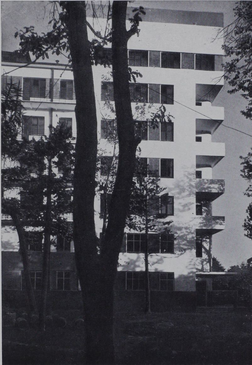
Abb. 50. Wohnhaus. Gebaut von Mossowjet.
