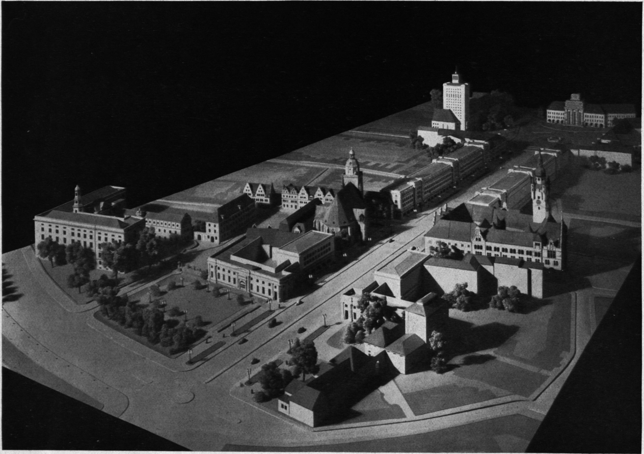
Blick von Nordosten in die neue Ost-West-Straße zwischen Muldbrücke und Stadtmittelpunkt
