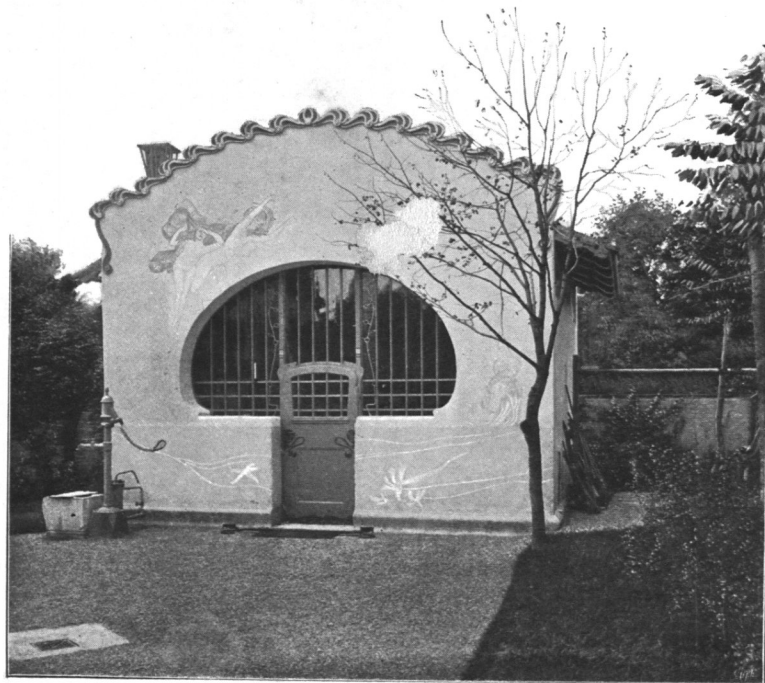
PUMPENHAUS · VILLA FRIED · MANN · HINTERBRÜHL
