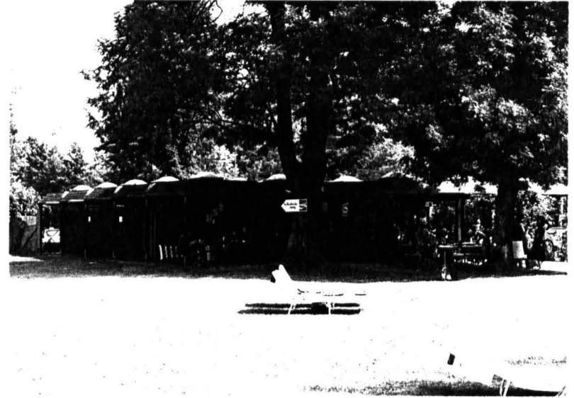
Abb. 78: Das Zentralgebäude im Loretto bad
