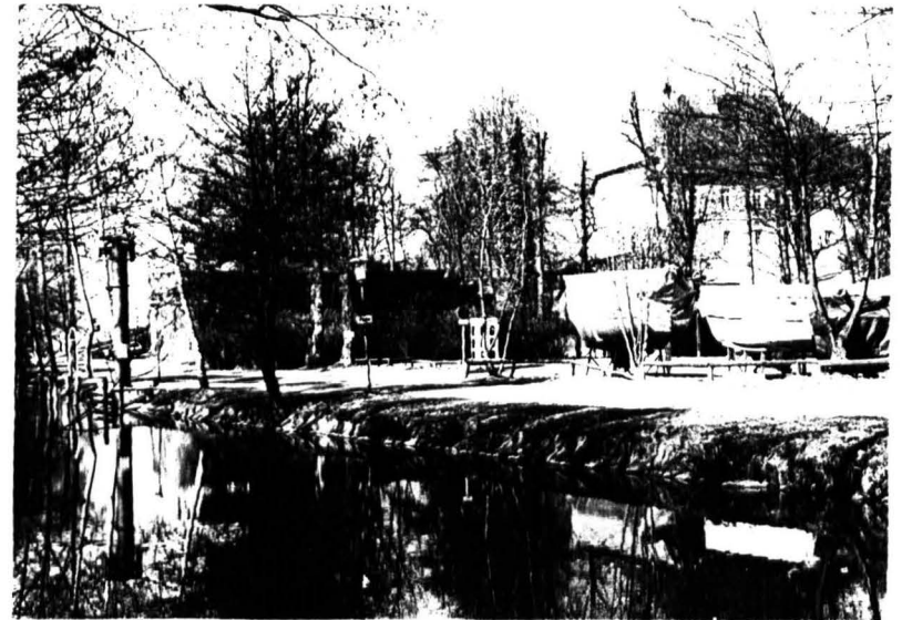
Abb. 52: Winterlager und Boots Kran am Lendkanal
