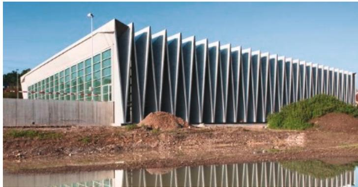
*Abbildung 1.9: Faltwerk aus Spannbeton bei Fertigstellung [9]*
