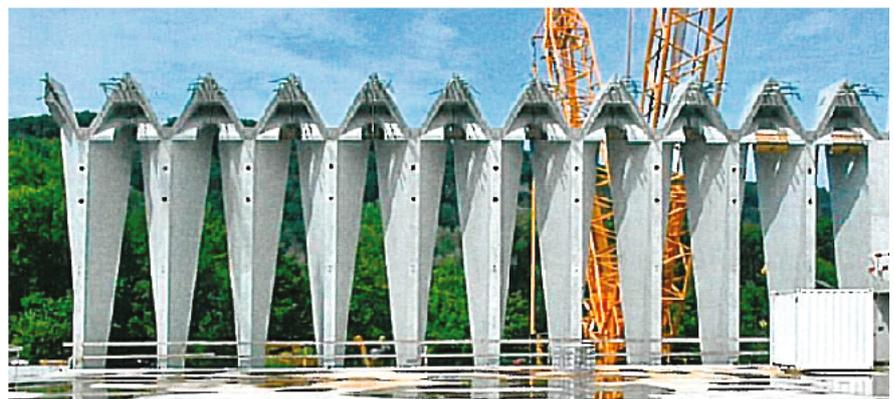
*Abbildung 1.8: Faltwerk aus Spannbeton bei Herstellung [52]*
