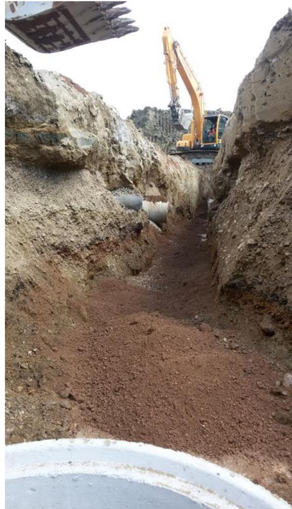
Abb. 57: Ummantelung der Messketten 1 mit Kabelsand
