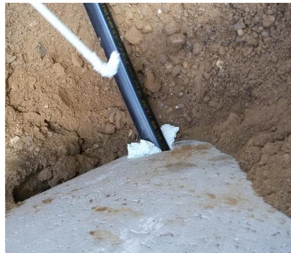
Abb. 55: Abdichtungsmaßnahme des Schachtes
