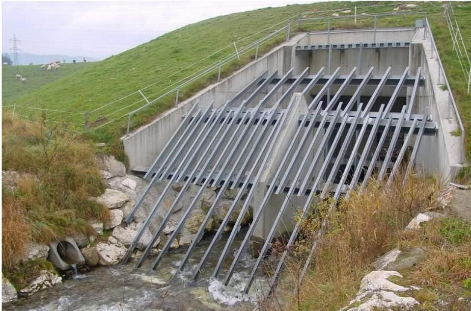
Abb. 12: Einlaufbauwerk des RHB Fressnitzbach-K., Aufnahme vom 14.11.2010 [10]
