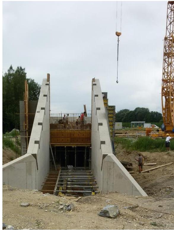
Abb. 24: Einlaufbauwerk in der Bauphase, Aufnahme vom 13.07.2016
