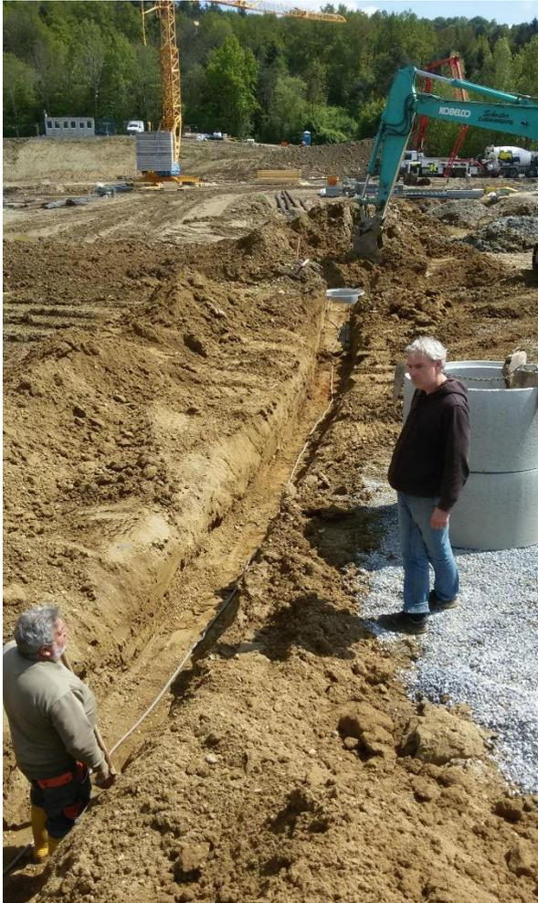
Abb. 59: Verlegung des Stromkabels zwischen SAA1 und SAA2
