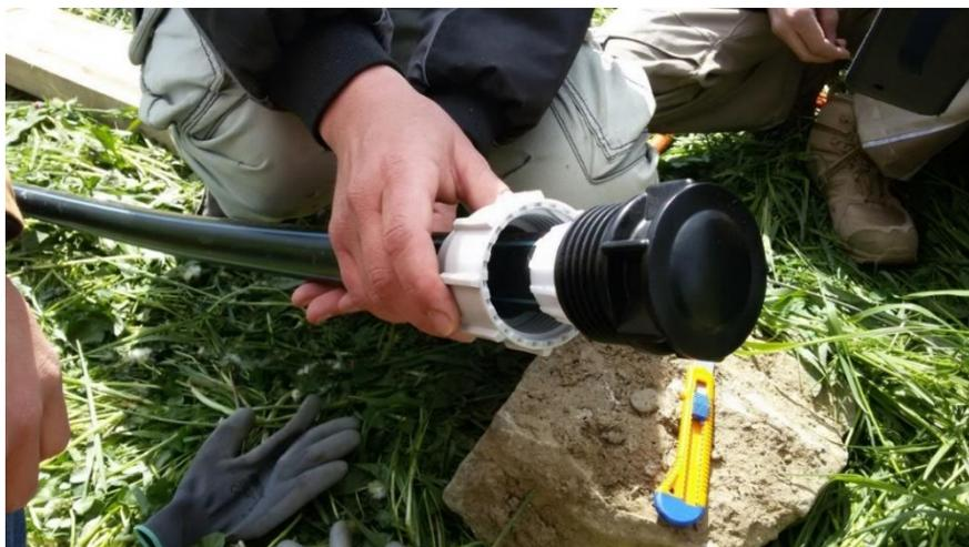
Abb. 46: Verschließen des Wasserschlauches
