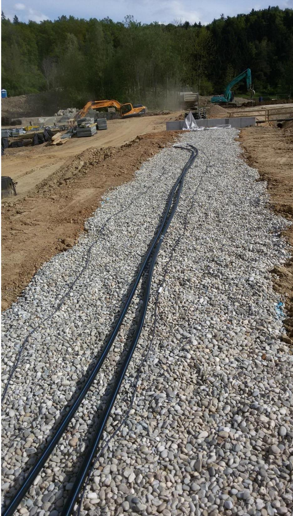
Abb. 47: Eingezogenen SAA Messketten im Wasserschlauch
