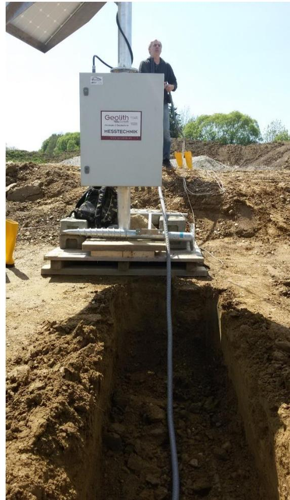
Abb. 60: Verlegung des Stromkabels zur Bodenstation
